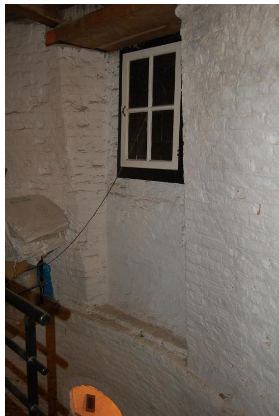
Fig. 22: Dezelfde dichtgemetste deur aan de binnenzijde van de molen.
