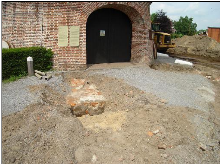
Fig.9: L-vormige muurfundering in baksteen aan de zuidzijde van de ingangspoort.
