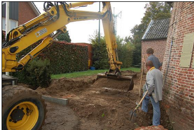
Fig. 12: Beeld van de werkzaamheden van het VIOE op 15-09-2009.
