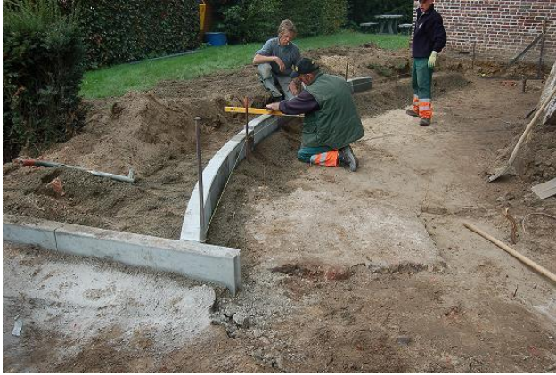
Fig. 29: Aanleggen van de borduurstenen rond de funderingspijlers.
