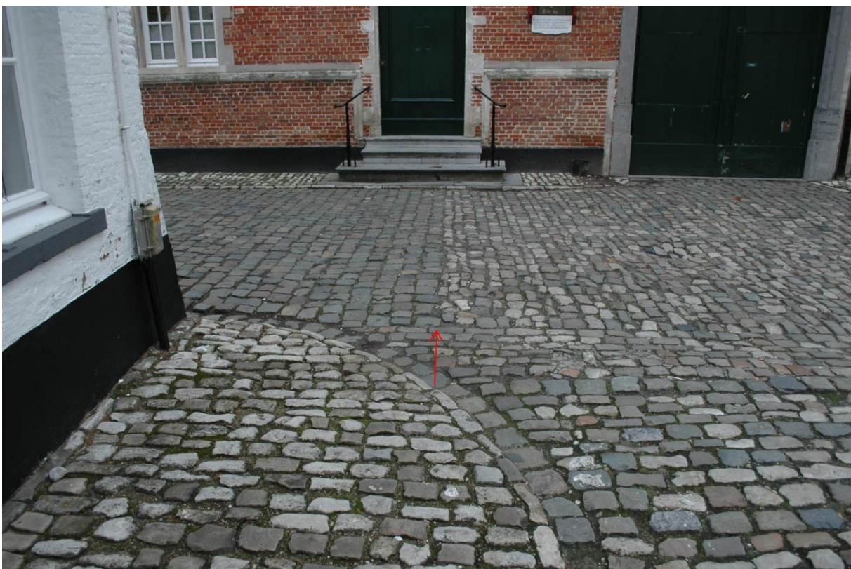
Fig. 25: Zicht op de overgang tussen de recenter herlegde bestrating en de oude bestrating, ter hoogte van de kruising van het Oud Kerkhof en de Sint-Margarethastraat.
