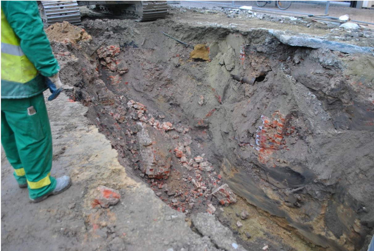
Fig. 29: Uitgraven van een rioleringsleuf zonder het plaatsen van metalen beschoeiing. Doordat de sleuf zo snel mogelijk weer gedicht moet worden (inkalving) is het niet mogelijk veel waarnemingen te doen of de nodige tijd te krijgen om iets op te kuisen of te registreren.
