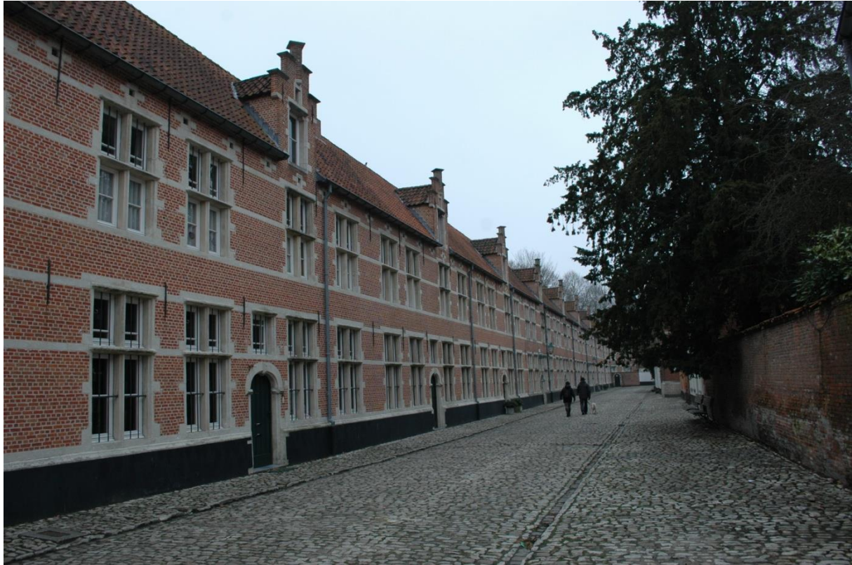
Fig. 8: Zicht op de huizen langs de Grachtkant.
