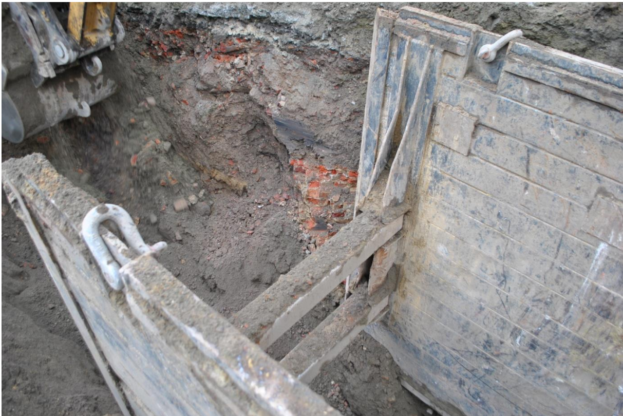
Fig. 28: Gebruik van metalen beschoeiing tijdens de aanleg van riolering op het Fochplein te Leuven.
