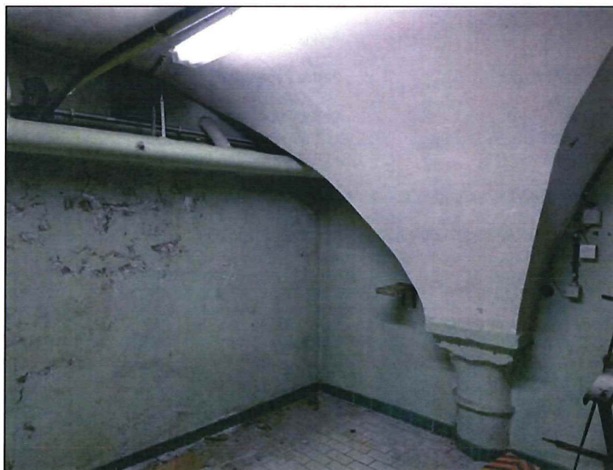
Figuur 1: De middeleeuwse kelder met Doornikse pijler
