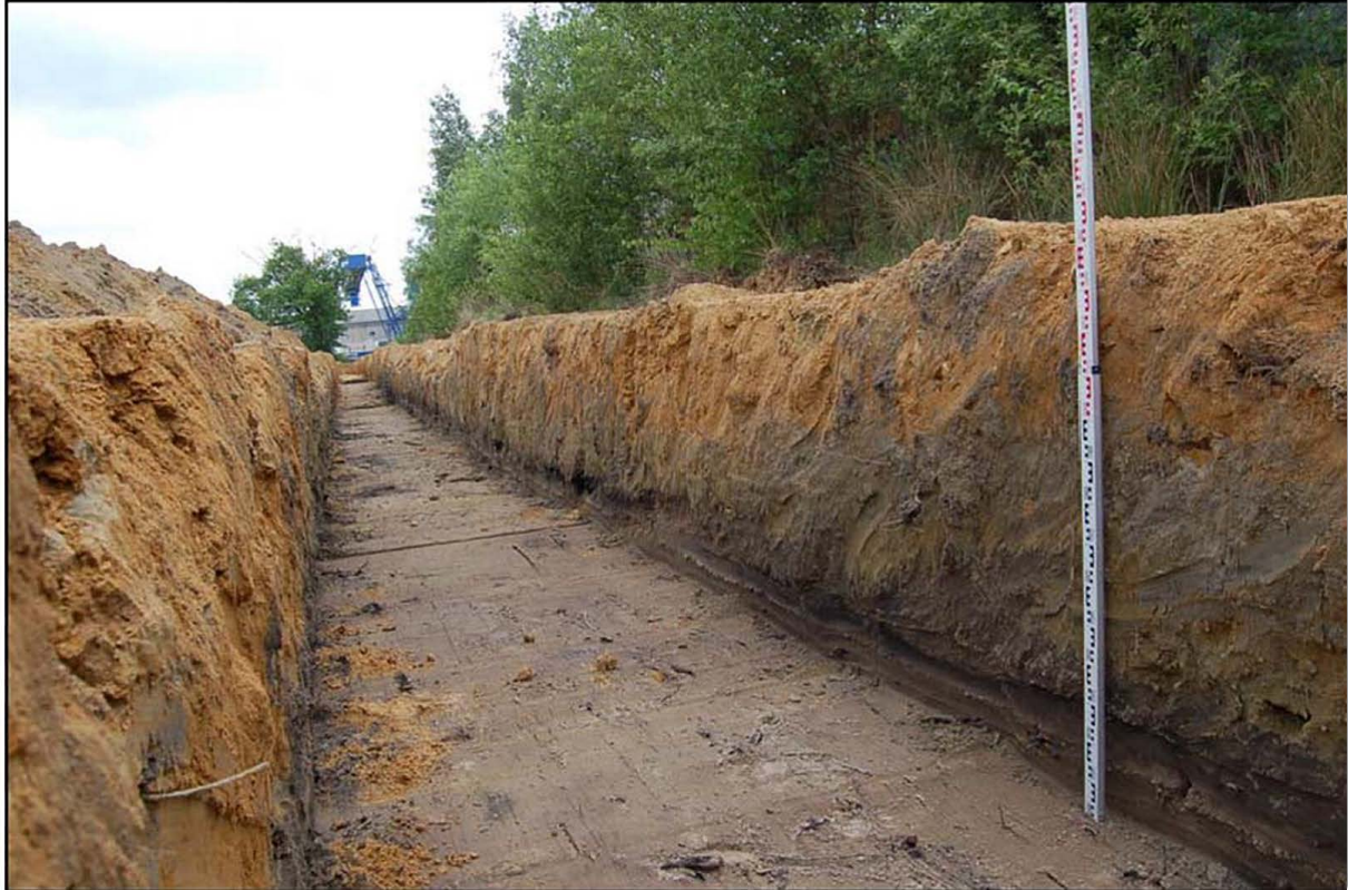
Afb. 4: Overzicht sleuf 1. Het terrein werd opgehoogd met een geel-oranje zand -en grindpakket. Het aangevulde pakket bleek plaatselijk tot 1.5 m dik te zijn. Hieronder situeerde zich de 'historische' bouwvoor over een diepte van ca. 50 cm (ARON bvba).
