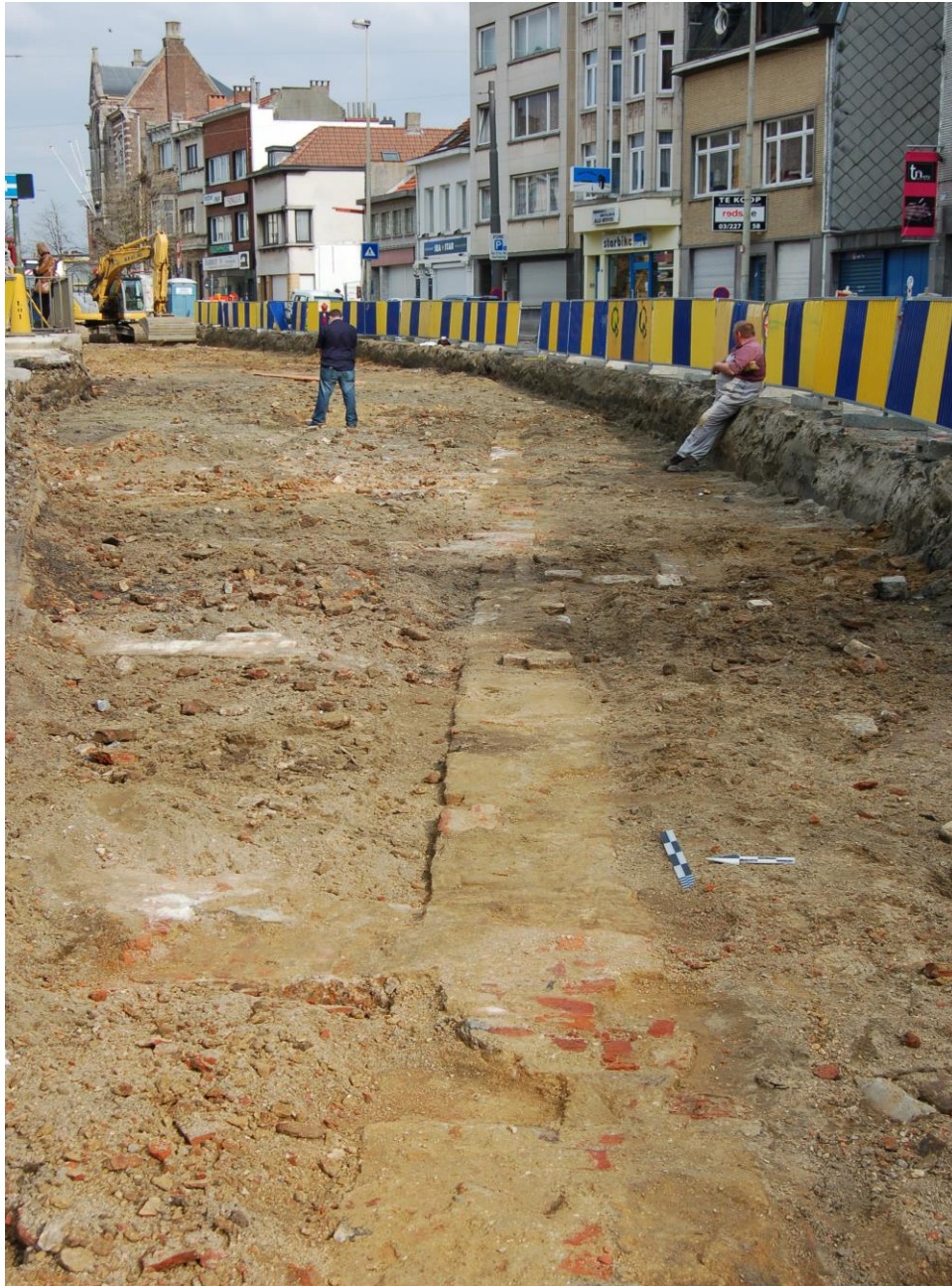
Foto 3: overzicht werkput vanuit ZW: westelijk gebouw
