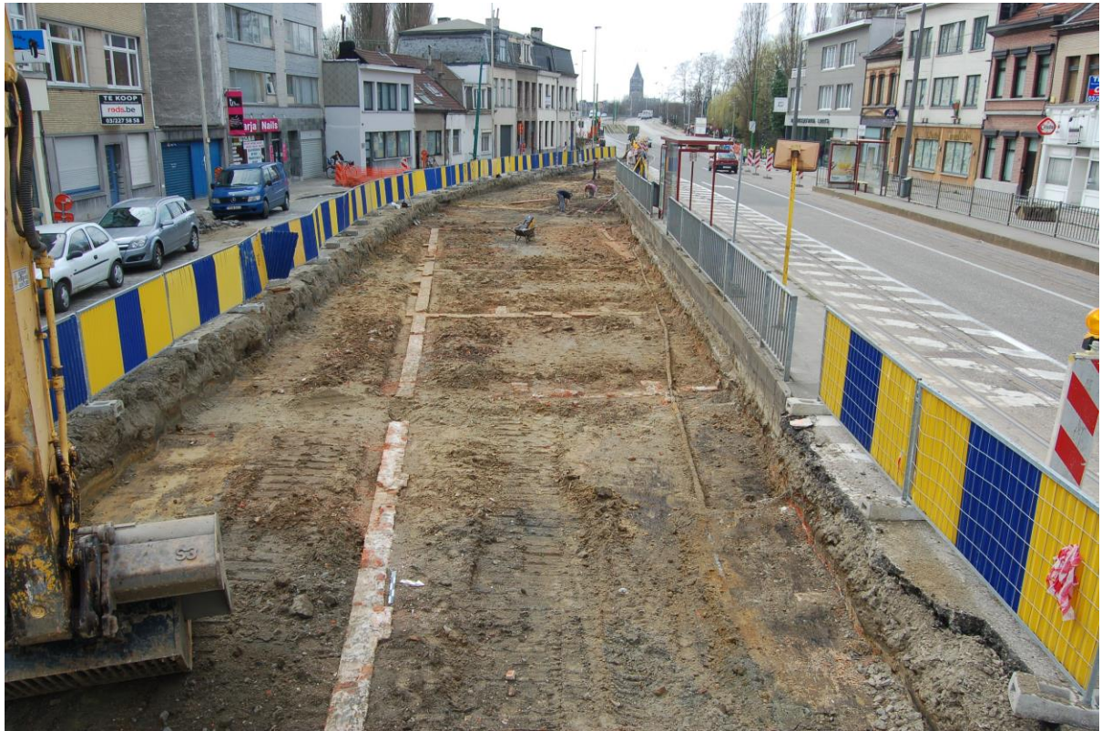
Foto 1: overzicht werkput vanuit NO: oostelijk gebouw
