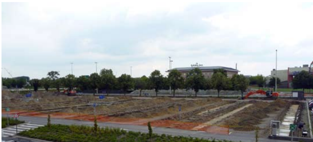
Figuur 6: Werkzaamheden op parking 1A
