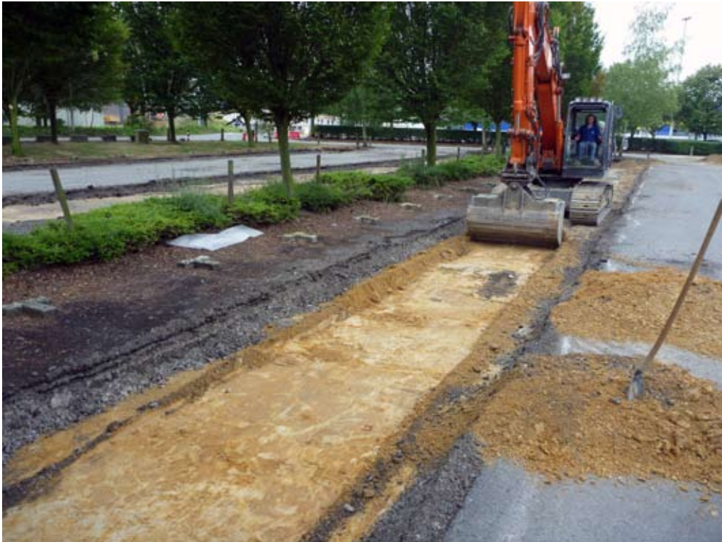
Figuur 7: Het aanleggen van een proefsleuf op parking 1C
