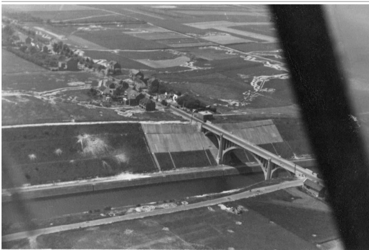
Fig. 1.8: Luchtfoto met de brug van Vroenhoven en bunker M (uit: Loopig et al. 2016; privaat archief Patrick Leenders).
