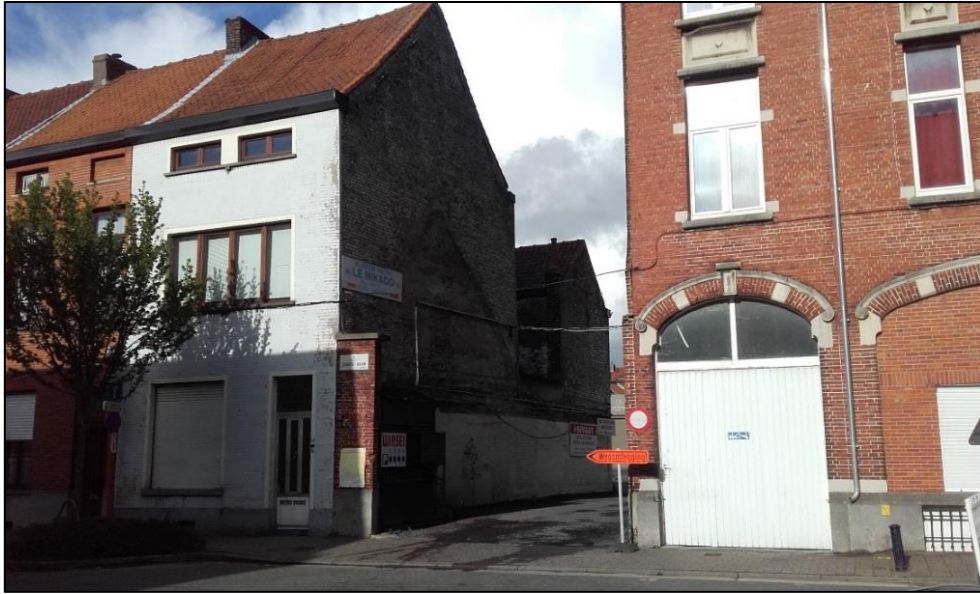
Figuur 4: Het te slopen pand aan de straatkant, links van de doorgang tot het achterliggend gebied, april 2016. 6)
