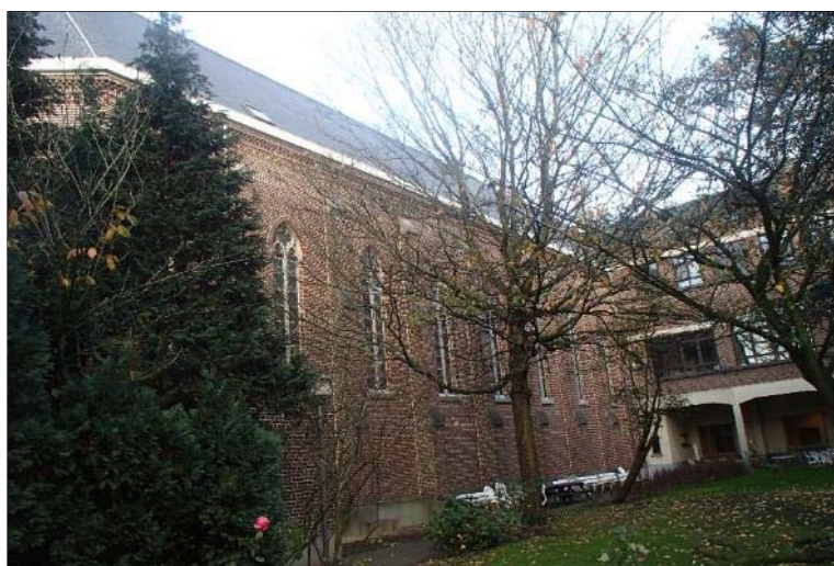
Figuur 11: Achterzijde van de kapel, foto richting noordoosten.
