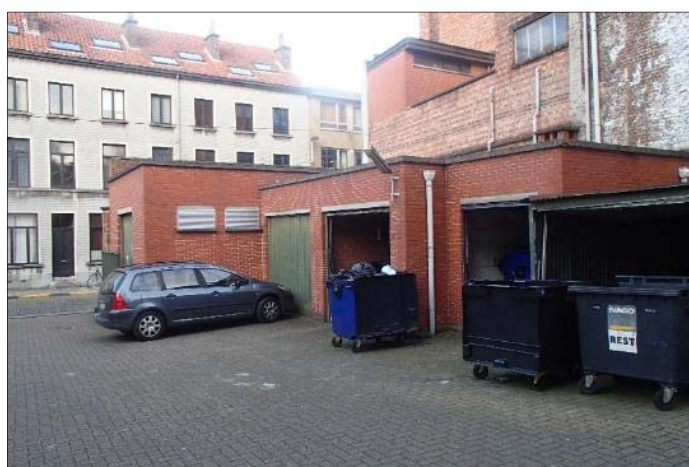
Figuur 6: Elektriciteitscabine en garages aan de Brandstraat. Foto richting noordoosten.
