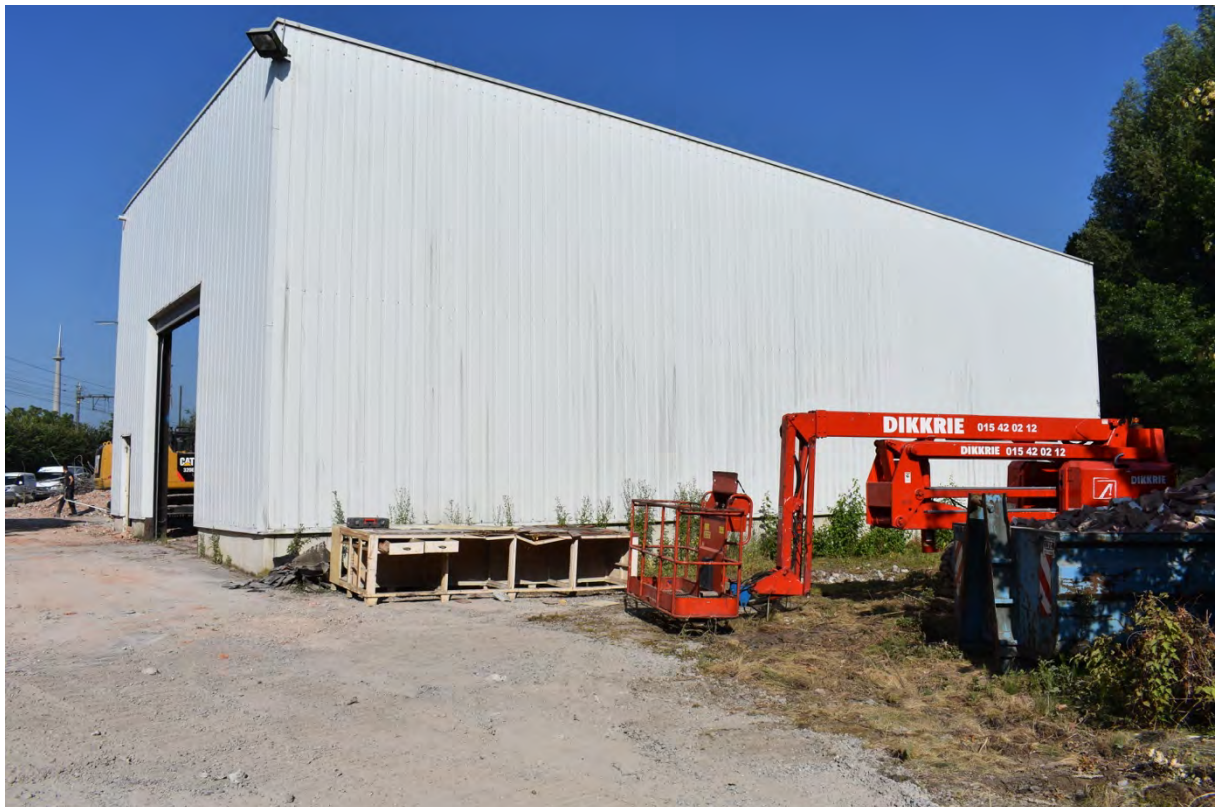
Fig. 3.5: Zicht op de (industriële) bebouwing.
