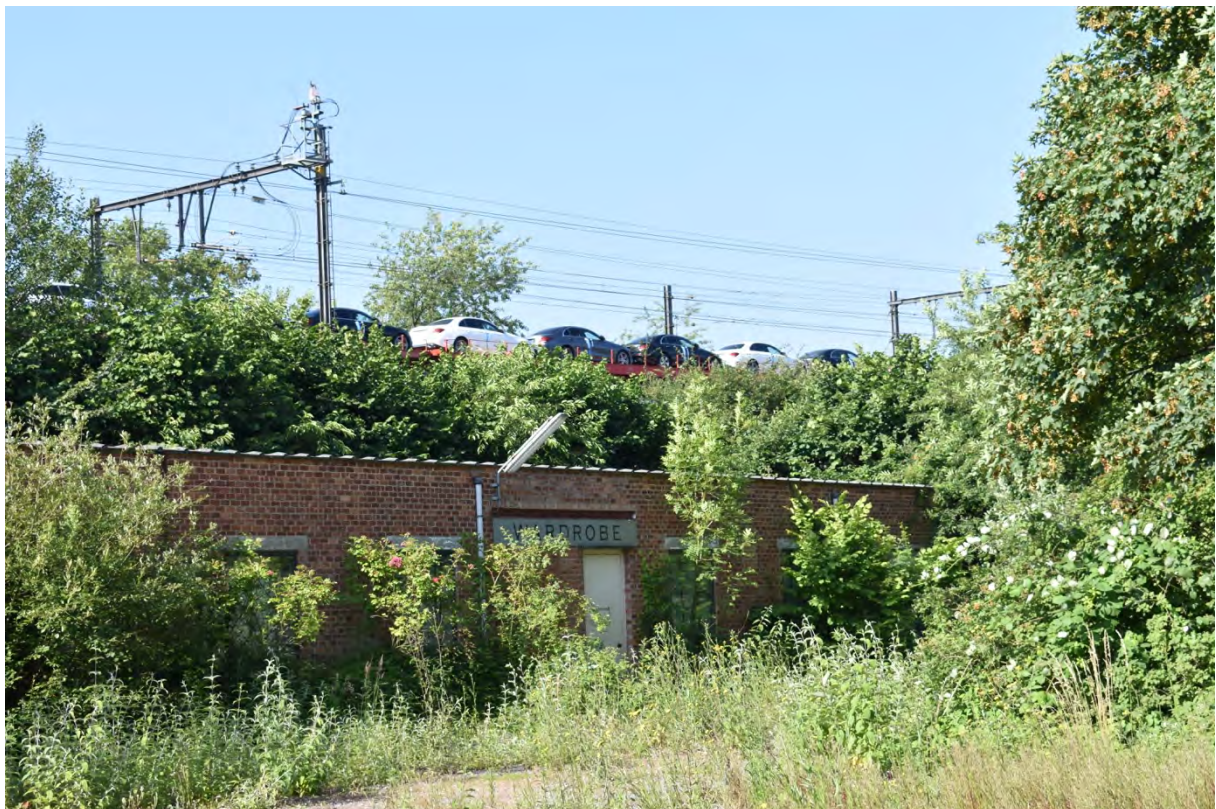
Fig. 3.6: Het talud van de spoorweg Mechelen-Dendermonde.
