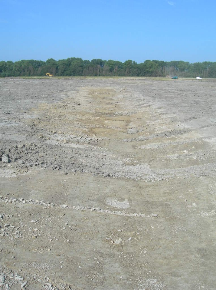
Figuur 8 Afgraving in het centrale gebied.
