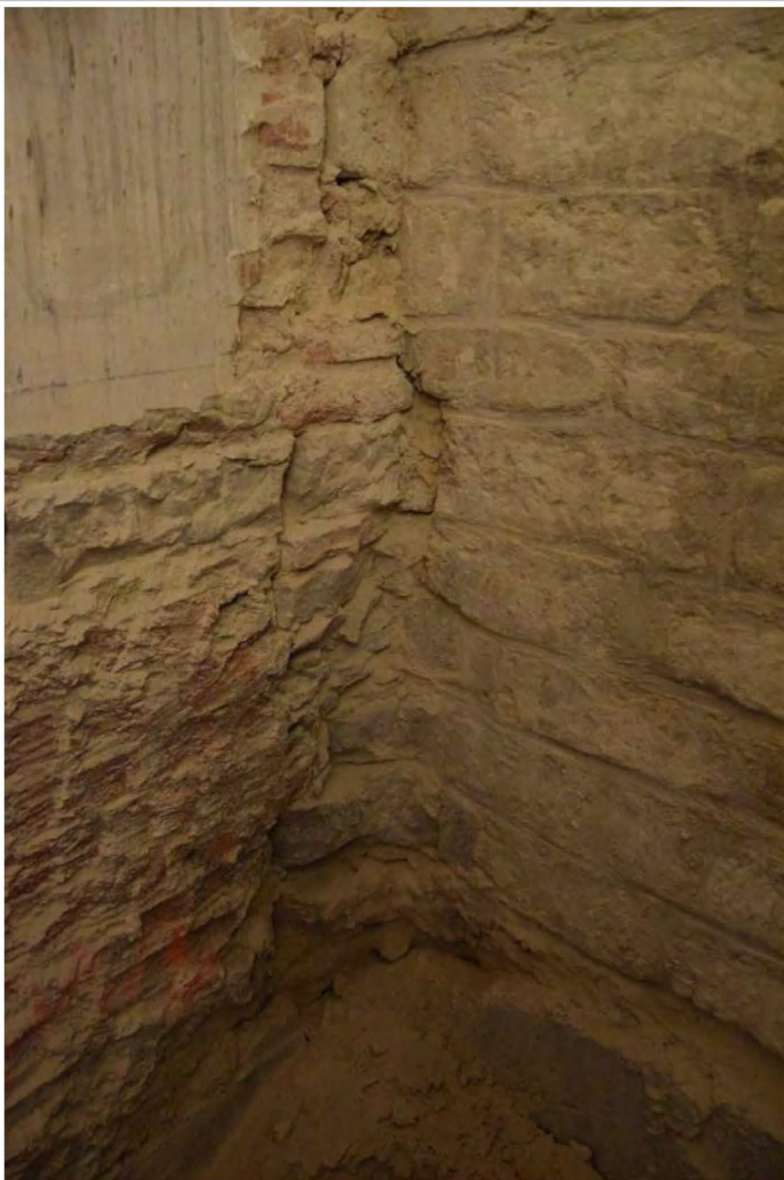
Fig. 4.26: Bouwnaad tussen de westgevel en de toren in de noordwestkapel.
