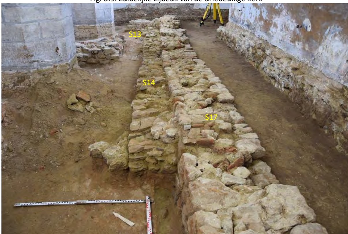
Fig. 3.10: Funderingen S13 en S14 tegen fundering S17.
