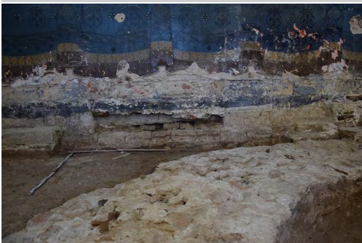
Fig. 4.15: De oostelijke deuropening in de zuidmuur van het huidige koor.
