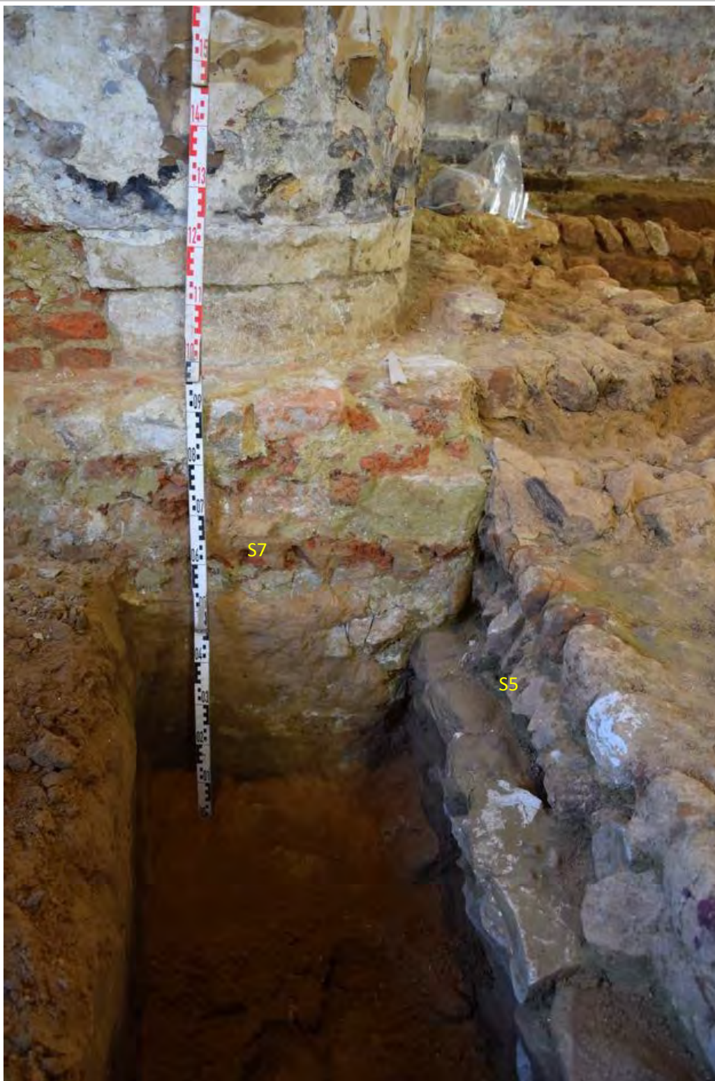
Fig. 4.21:Torenfundering S7 is tegen de westmuur van de driebeukige kerk aangebouwd (S5).
