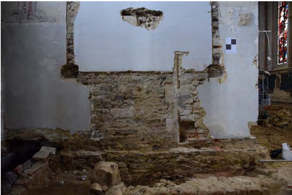
Fig. 4.20: Dichtgemaakte deuropening in de westmuur van de noordelijke zijbeuk.
