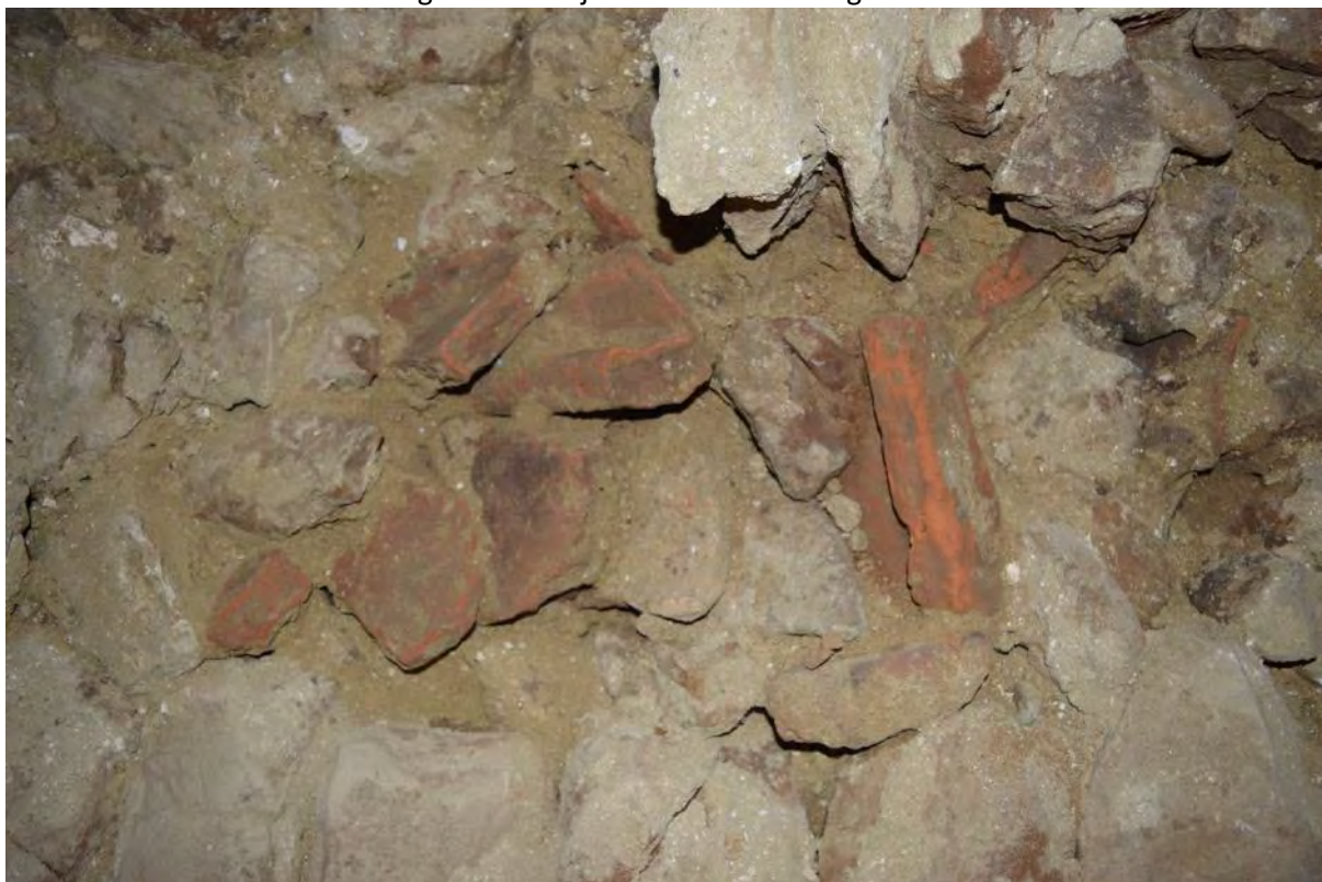
Fig. 3.8: Hergebruikte Romeinse dakpannen in situ in fundering S8.
