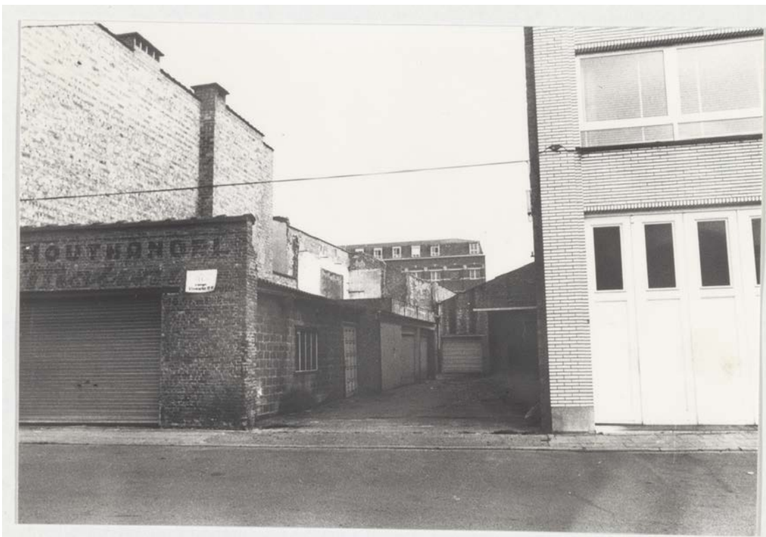
Fig. 3.24: Zicht op de overblijfselen van het refugium van de abdij van Aulne (1975) 23
