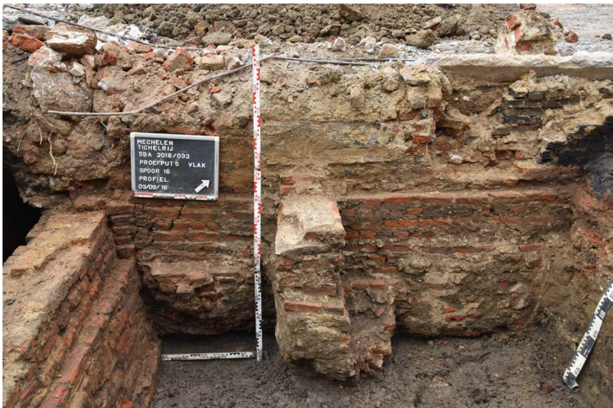
Fig. 4.29: Funderingsmuur (S16) die duidelijk tegen een ouder muur (S17, links) is gebouwd.
