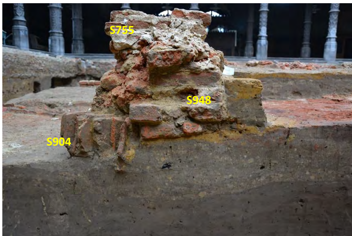
Fig. : 7.20: Muur S755 op muur S948.
