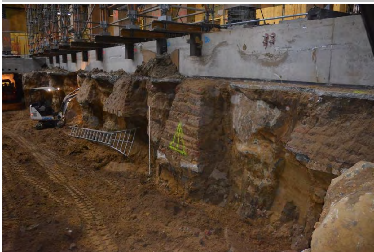
Fig. 8.4: Bakstenen funderingsvoeten van de pilaren van de Handelsbeurs.
