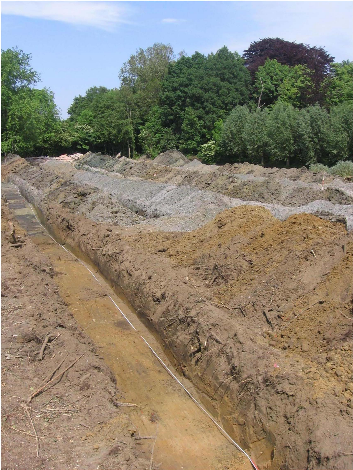
Figuur 10: Zicht op de uitgegraven sleuven vanuit het zuidwesten.
