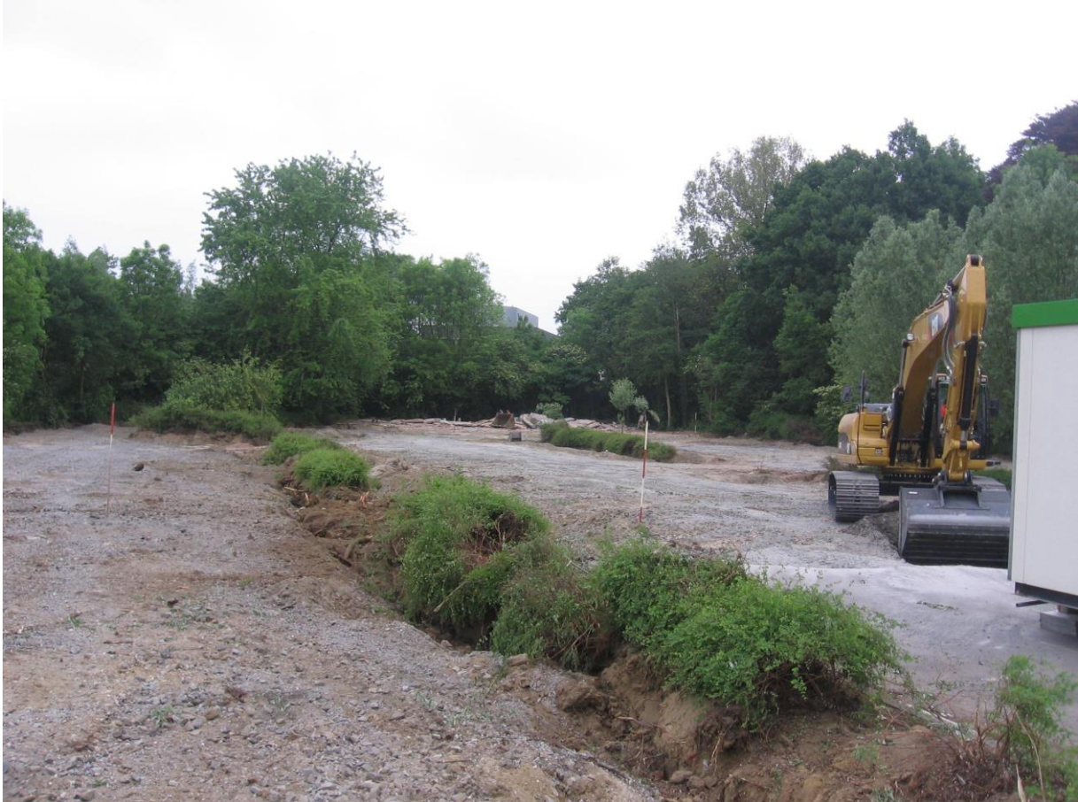
Figuur 7: Overzicht van de site (gezien van uit het zuiden) net voor aanvang van het graven van de eerste sleuf op 5 mei 2007.
