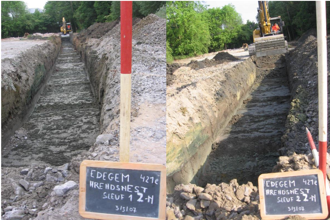
Figuur 9: Zicht vanuit het zuiden op het geleidelijk uitdiepen van sleuf 1 en 2 door de geniekraan. Bemerk de sterk heterogene aangevoerde lagen in het westelijke profiel van sleuf 2
