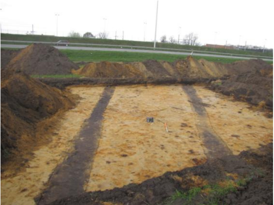
Afb. 17: Kijkvenster 4 met twee parallelle greppels (S135 en S136)
