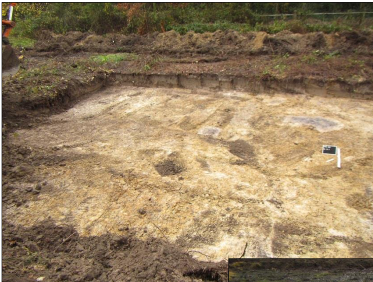
Fig.16 en 17: zicht op kijkvensters SL12-KV22 en SL16-KV26
