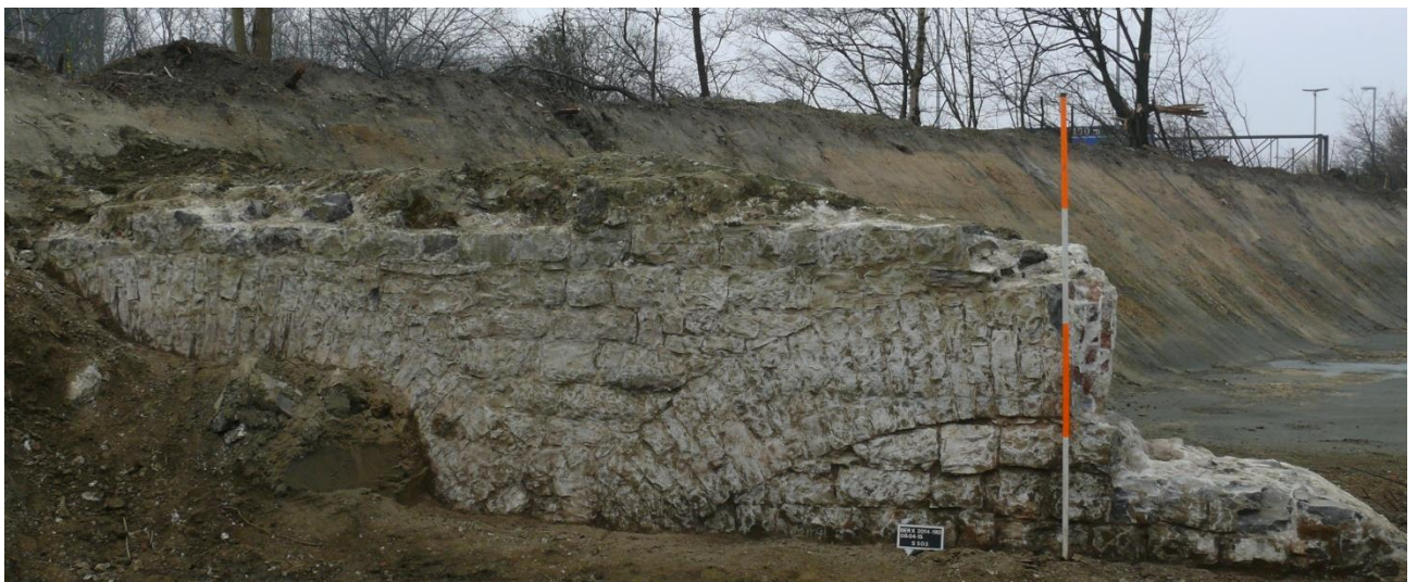
Figuur 28: zicht op de zuidelijke keerwand (502) gezien vanuit het noorden
