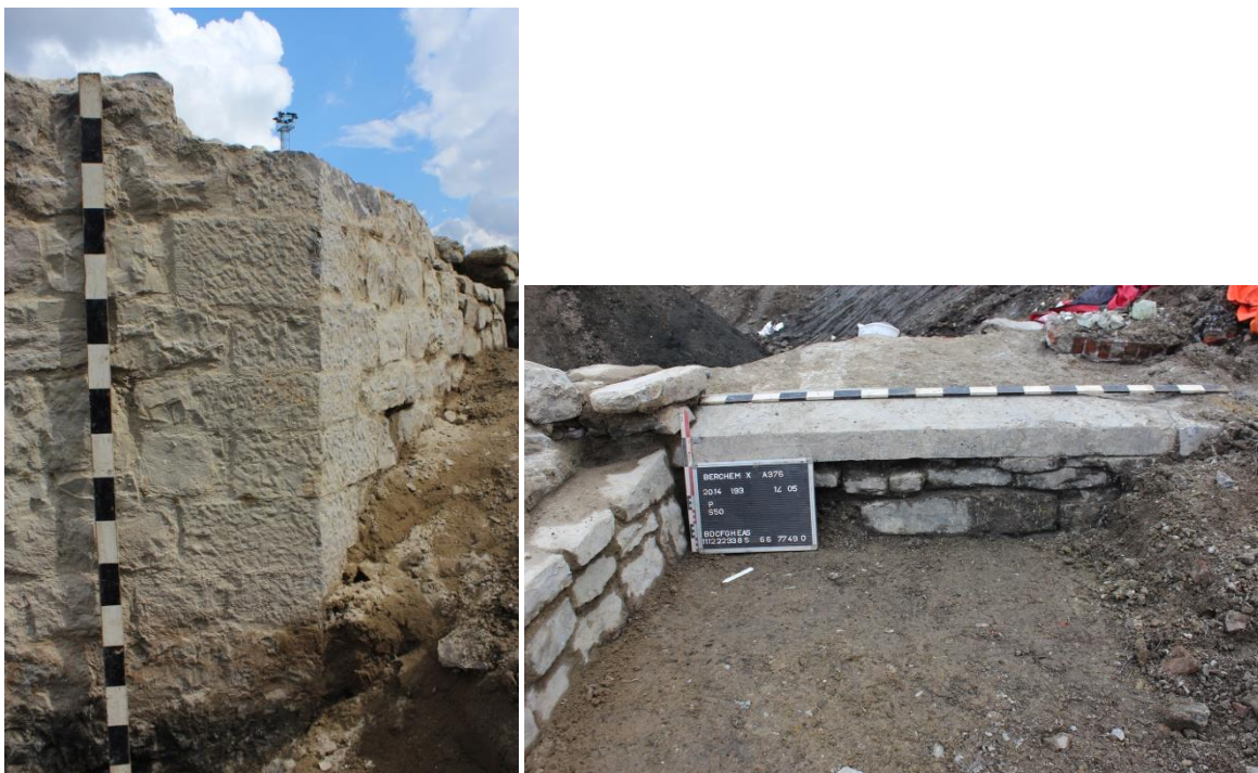
Figuur 16 Links: Hoek van het bruggenhoofd naar de keerwand; Rechts: Deksteen ter hoogte van de keerwand.
