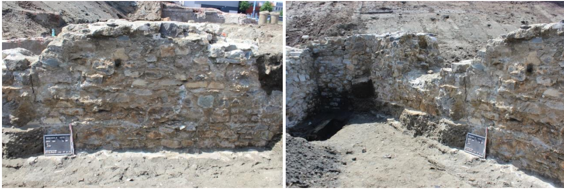
Figuur 15: zicht op de oostelijke muurzijde van het bruggenhoofd.
