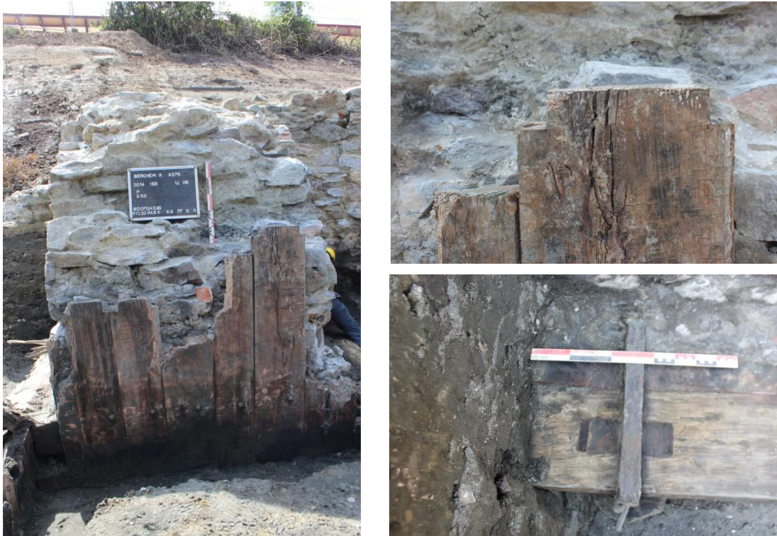
Figuur 18: links: horizontale planken aan de oostelijke zijde van de muur; rechtsboven: detail van de bovenzijde van de planken waar zich de pen bevindt; rechtsonder: Detail van de basis met een pen-en-gatverbinding met een verstevigend hoekanker.
