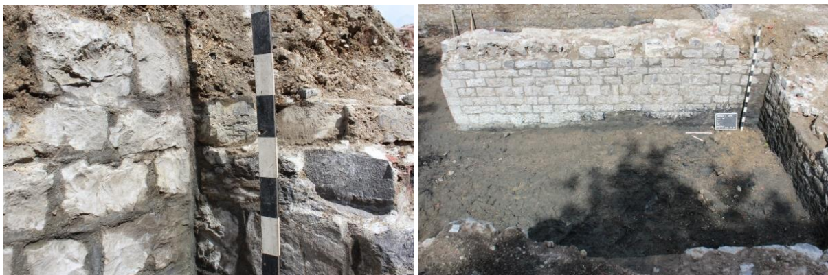
Figuur 23 links: overgang tussen spoor 23 en 22; rechts: zicht op spoor 20 gezien vanuit het zuiden.
