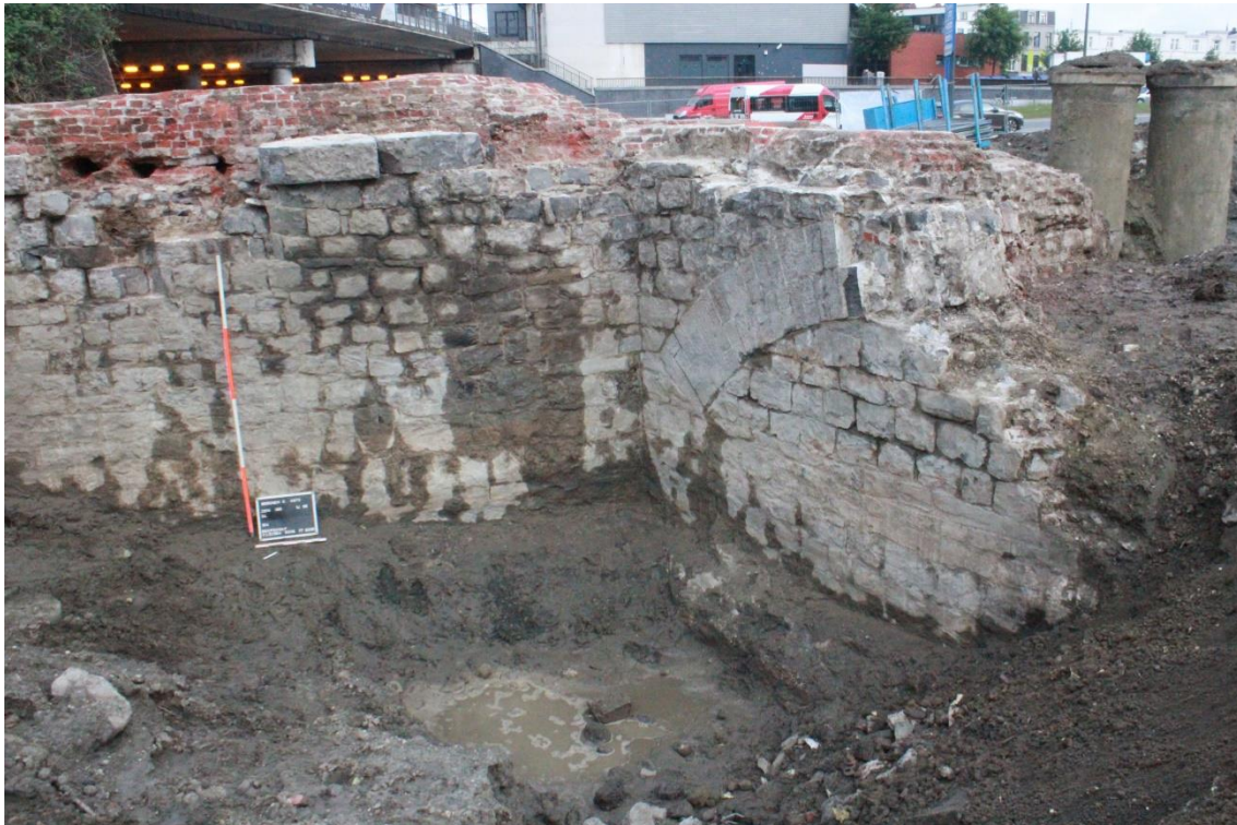
Figuur 21: overzichtsfoto van sporen 1 en 5 gezien vanuit het oosten. Rechts is de aanzet van een ontlastingsboog zichtbaar.
