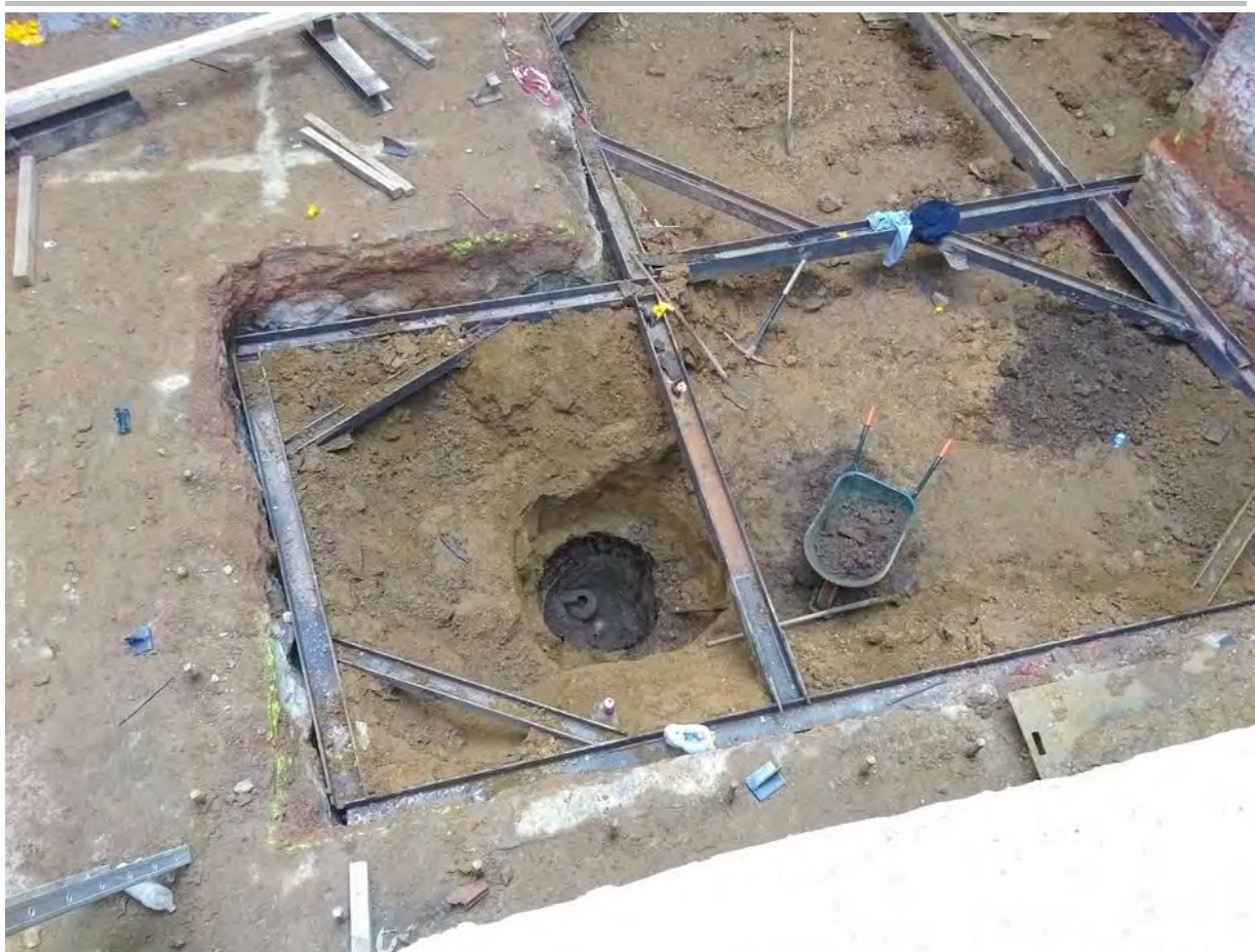
Fig. 9.5: Zicht op de waterput met op de bodem twee zichtbare kruiken.
