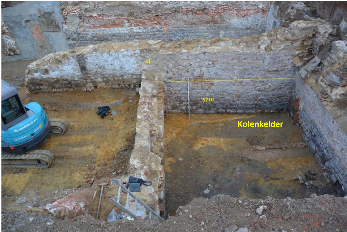
Fig. 3.21: Zuidmuur van de middelste kelder.
