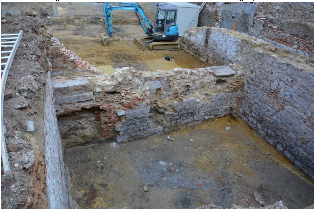
Fig. 3.23: Oostmuur van de middelste kelder
