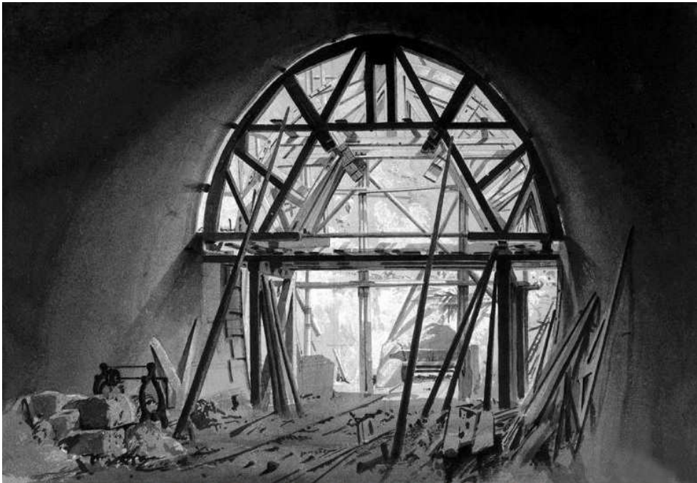
Figuur 35: Tekening van de constructiefase van de Northchurch Tunnel (John Cooke Bourne, 1837).
