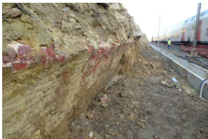
Figuur 29: Restanten van de tweede tunnel op grondgebied Roosbeek (Boutersem).
