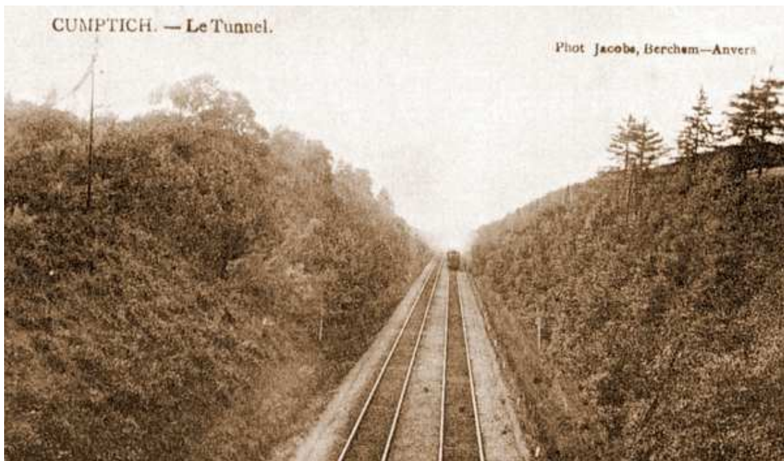
Figuur 6: De spoorlijn op de plaats van de vroegere tunnel.
