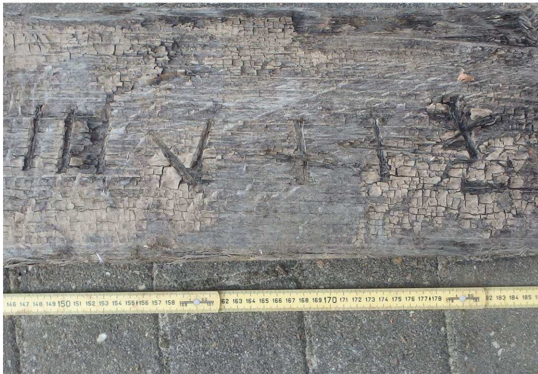
Figuur 38: Merk aanwezig op één van de balken (B9).
