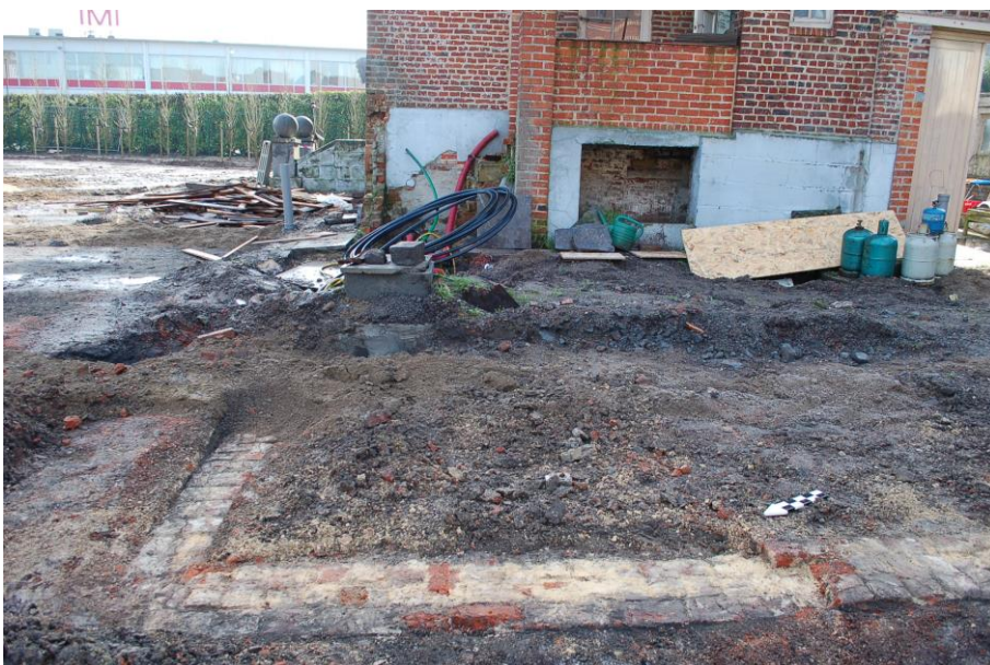
Figuur 24: Baksteenfundering spoor S3 en de afgebroken muur aan de portierswoning.
