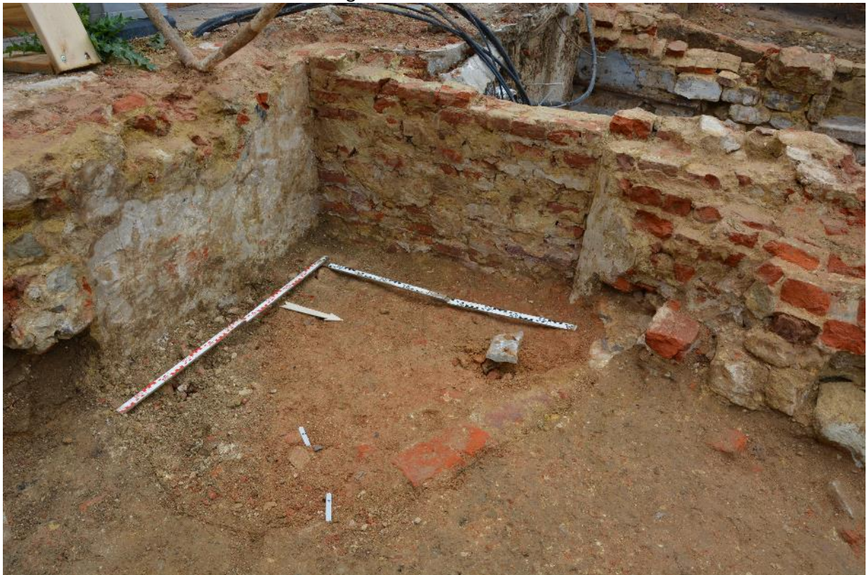
Fig. 3.10: Dichtgemaakte keldertoegang S153.
