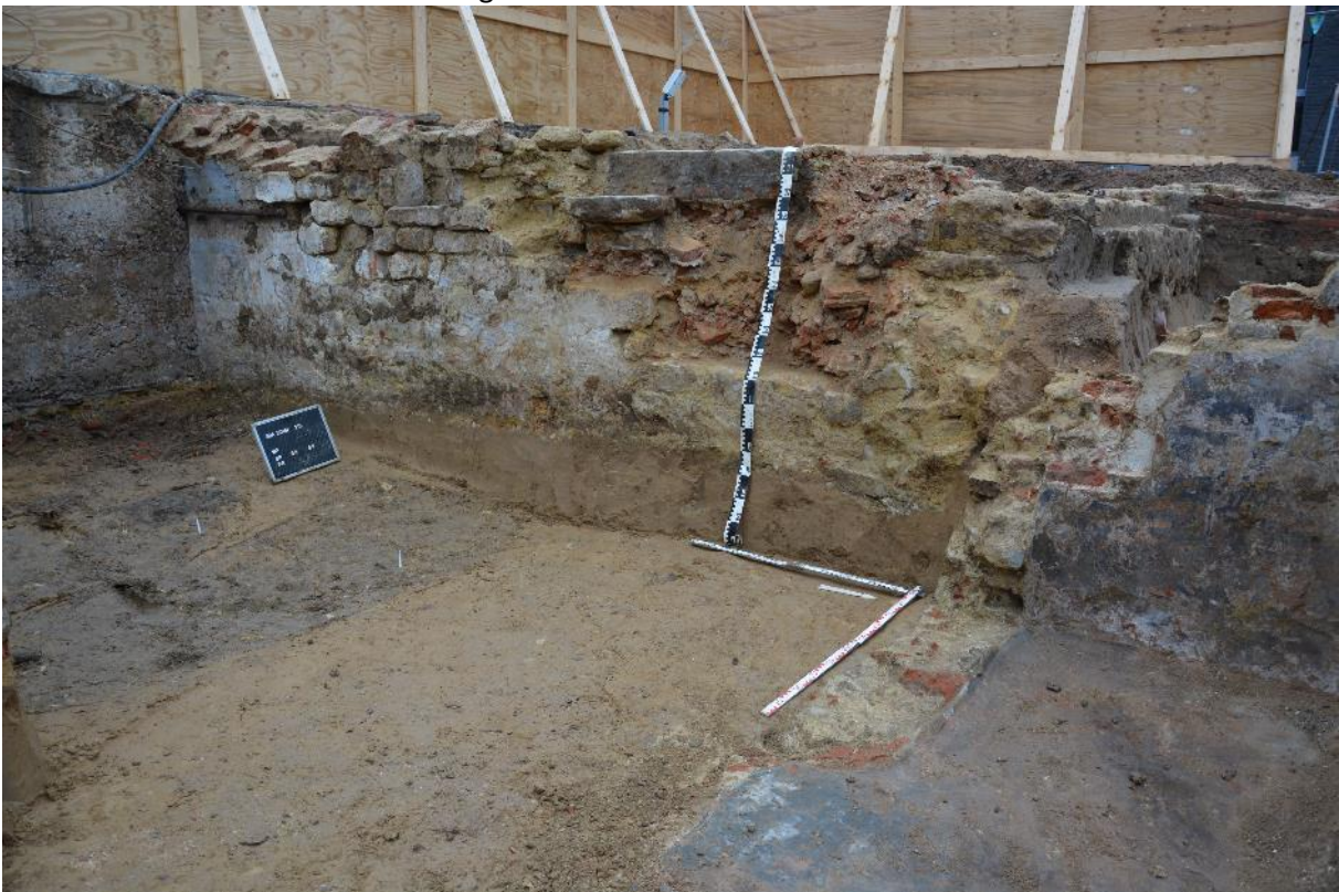
Fig. 3.6: Westmuur van rechthoekige overwelfde kelder.
