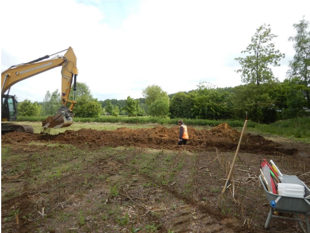
Fig. 19 : fotografische opname van de aanleg van een sleuf
