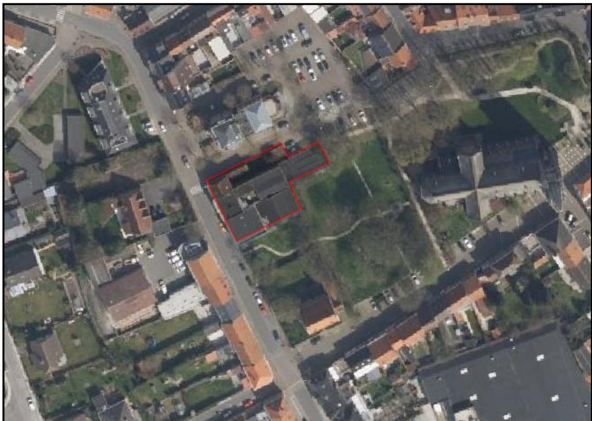
Figuur 3 Aanduiding van het onderzoeksgebied op de luchtfoto voor afbraak van de woningen (© http://www.geopunt.be ).
