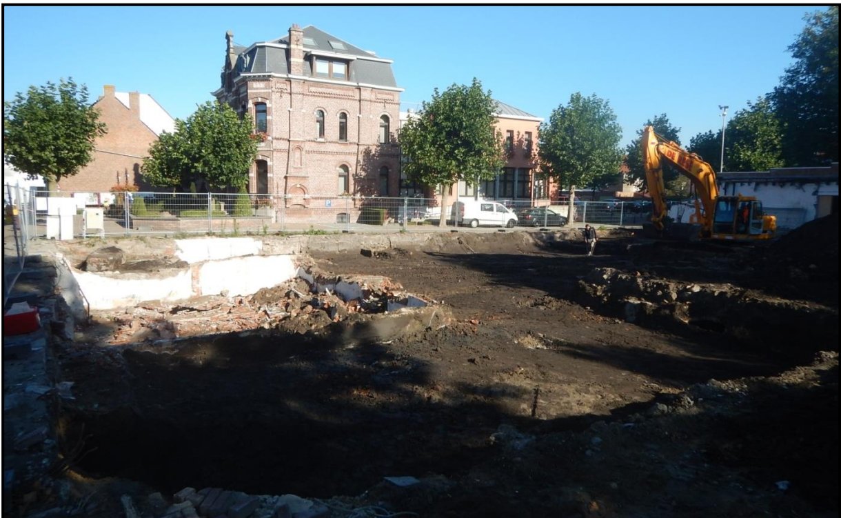
Figuur 21 Zicht op het tweede tussenliggende niveau op ca. 100 tot 150cm onder het straatniveau.
