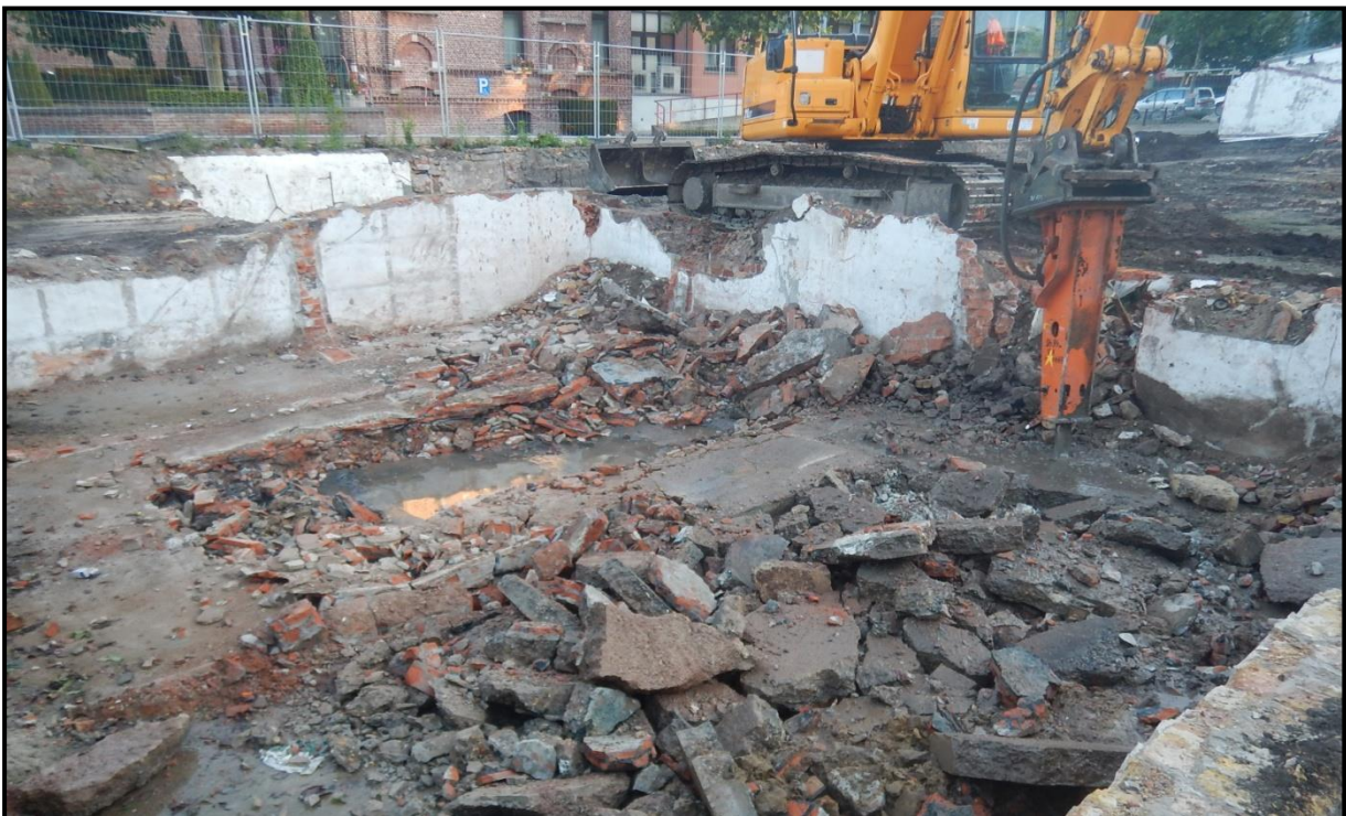
Figuur 19 Zicht op het losmaken van de vloer in de kelder (werkput 2).
