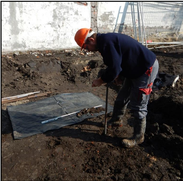
Figuur 25 Plaatsen van de boringen met een ondoordringbare verstoringslaag (voormalige kelder) op ca. 70cm onder het straatniveau.
