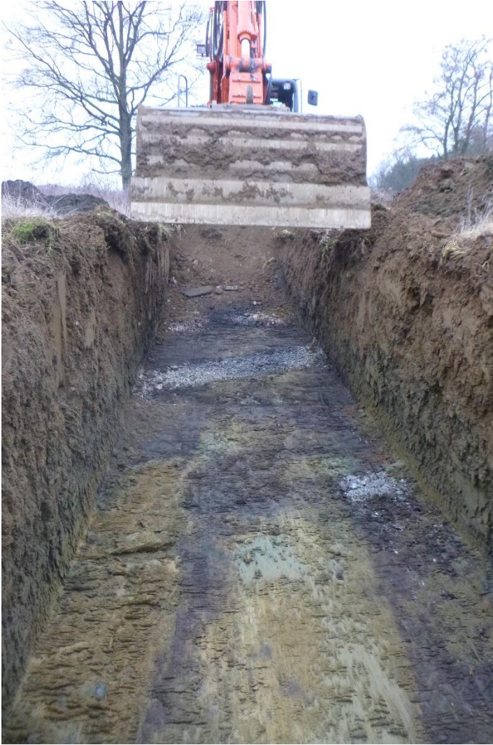
Figuur 15: Sleuf 2, werkfoto, illustratie: verbrijzeld beton in de sleuf
