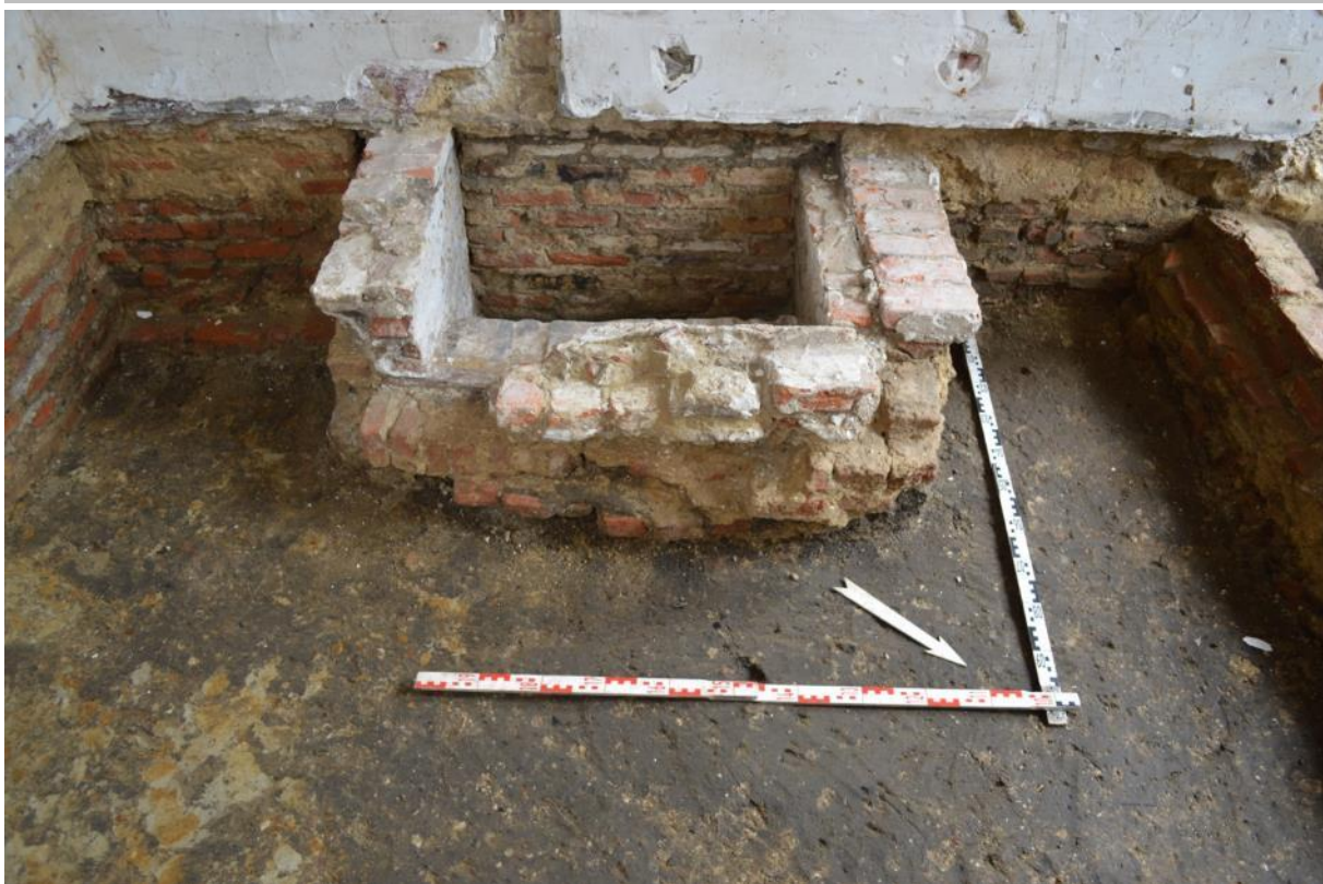
Fig. 4.66: Dichtgemaakte trap S 138 in ruimte 2.5
