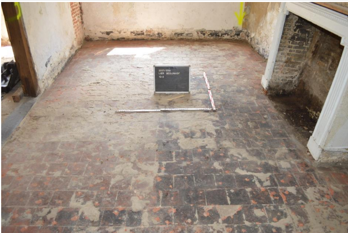
Fig. 4.2: Oudere vloer (S1) in ceramiektegels in ruimte 12.2.
