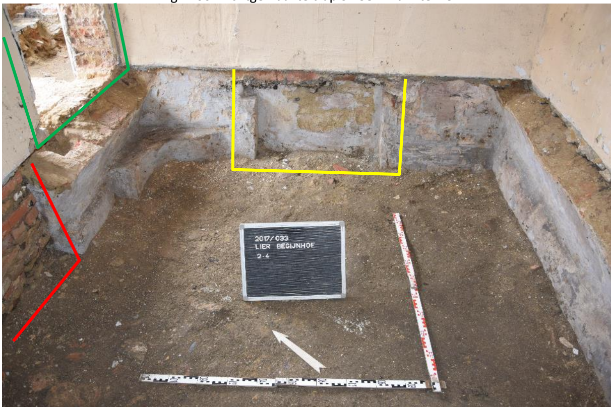
Fig. 4.67: Initieel gewelfde kelderruimte 2.4 met dichtgemaakte deuropening naar de aanpalende noordelijke ruimte 2.5 (geel), een recentere opening naar het westen (rood) en de huidige deuropening (groen).
