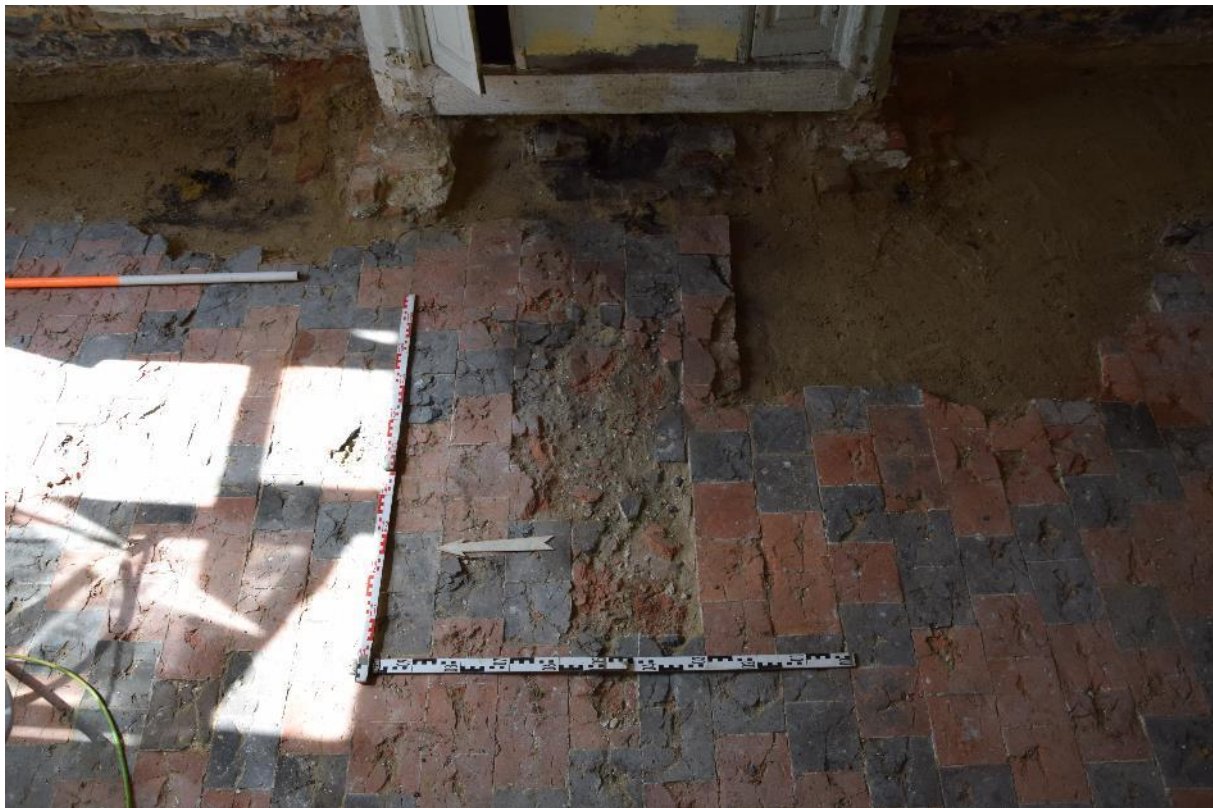
Fig. 4.17: Oudere vloer (S2) in ceramiektegels in ruimte 10.2.
