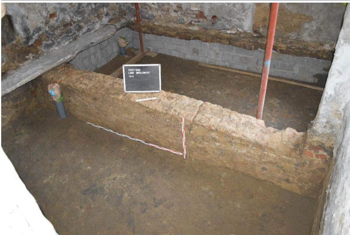
Fig. 4.7: Muur S31 in kelderruimte 12.4.
