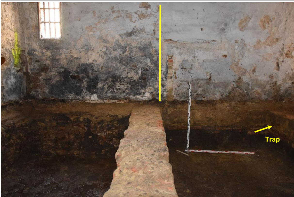
Fig. 4.21: Muur S64 in kelderruimte 10.4 met de bouwnaad in geel.
