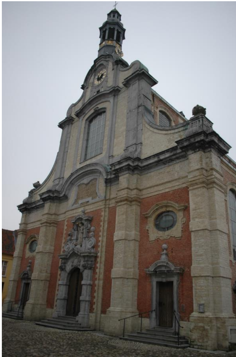
Fig. 1.6: Zicht op de barokke begijnhofkerk.
