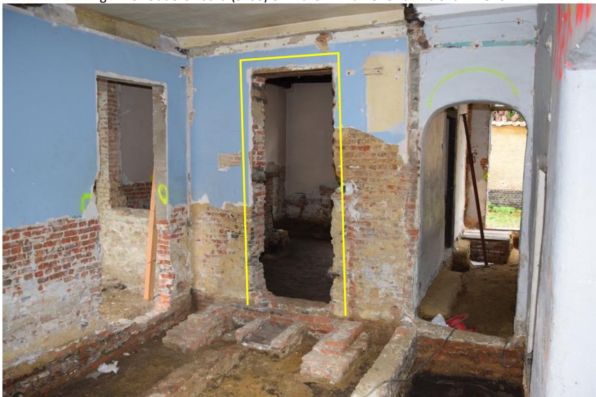
Fig. 4.50: Deuropening tussen ruimte 6.6 en 6.3 ter hoogte van de haard.
