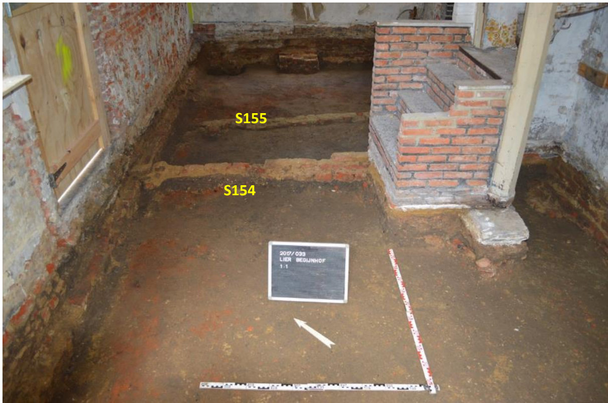
Fig. 4.72: De rechthoekige ruimte 1.1 met muren S154 en S155.
