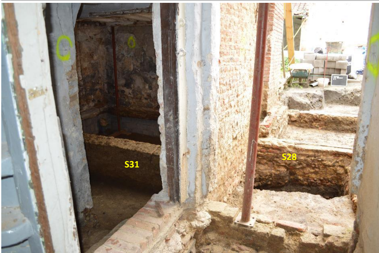
Fig. 4.11: Muren S31 en S28.
