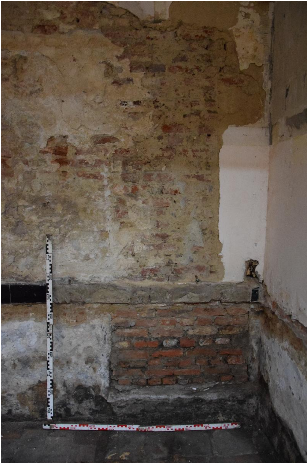
Fig. 4.41: Dichtgemaakte deuropening tussen ruimte 8.5 en 8.3.
