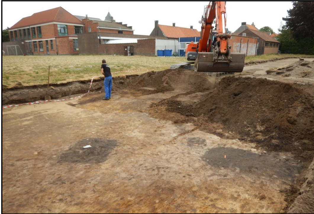
Figuur 38: Overzicht van kuil S120 en kuil S122 bij de aanleg van het vlak.
