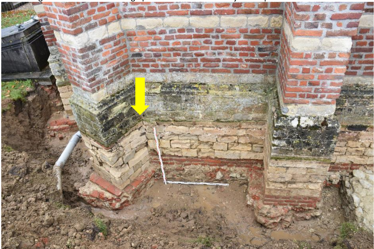
Fig. 4.8: Mogelijke bouwnaad tussen koor en koorafsluiting (rechts en links van gele pijl).
