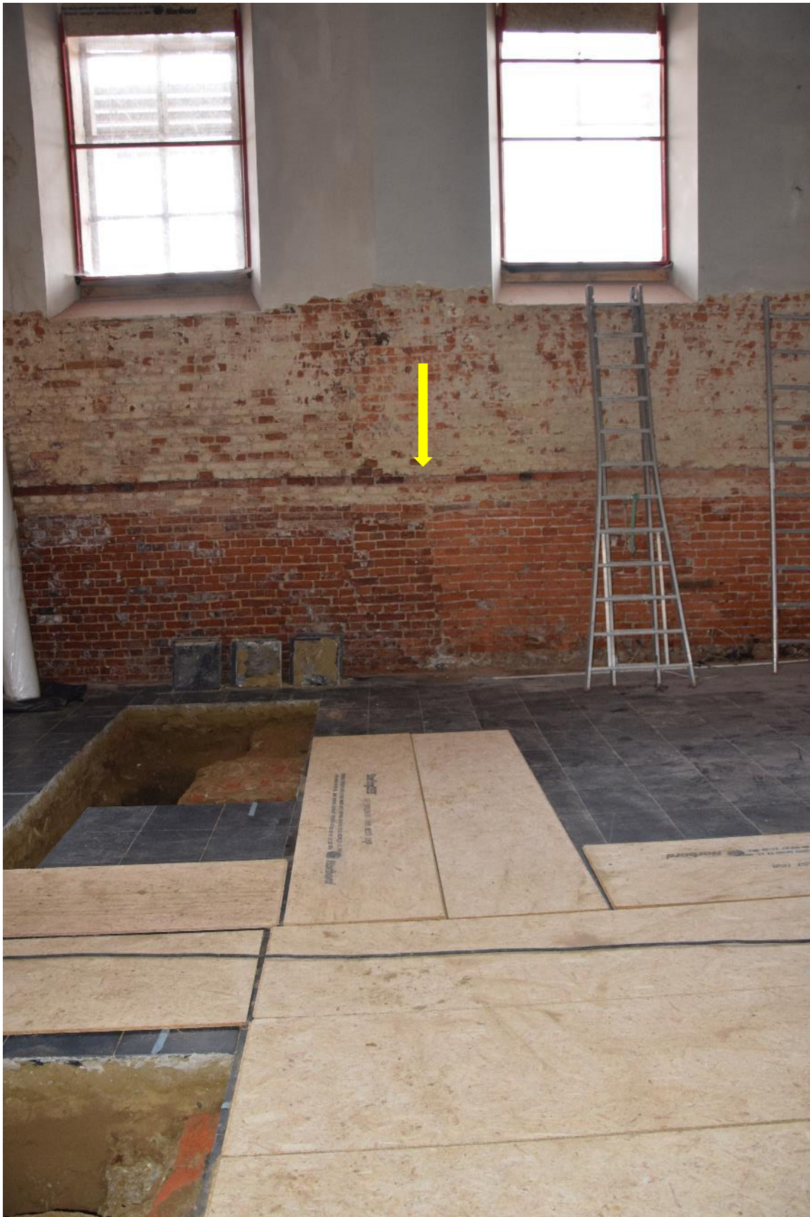
Fig. 4.5: Bouwnaad tussen schip en meest westelijke travee aan de binnenzijde.
