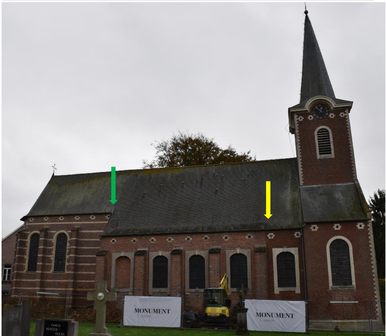
Fig. 4.6: Bouwnaad tussen koor en schip (groen) en tussen schip en meest westelijke travee (geel).
