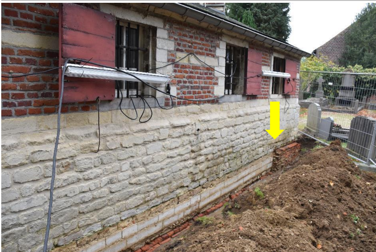
Fig. 4.7: Sacristie: Fundering op natuursteen aan westzijde en op baksteen in oosten.
