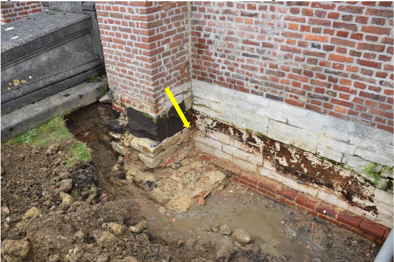
Fig. 4.4: Bouwnaad tussen schip en meest westelijke travee aan de noordzijde.
