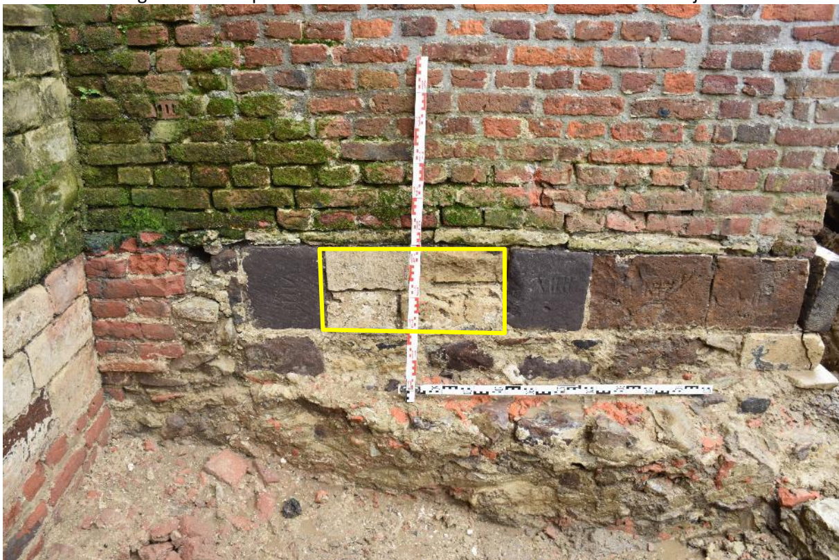
Fig. 4.15: Noordgevel: kleinere blokken in een rij met merk VIII.
