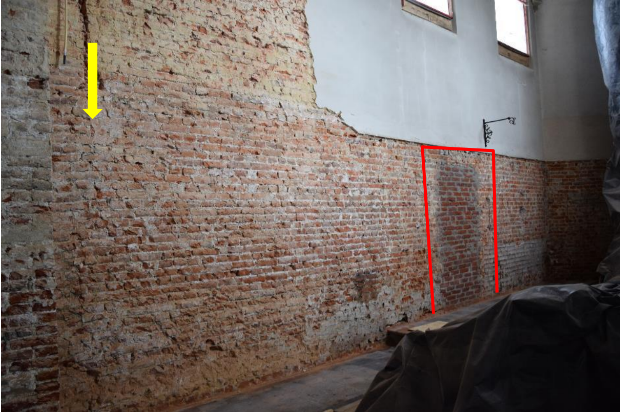
Fig. 4.3: Bouwnaad tussen koor en schip in noordmuur van koor en dichtgemaakte nis.
