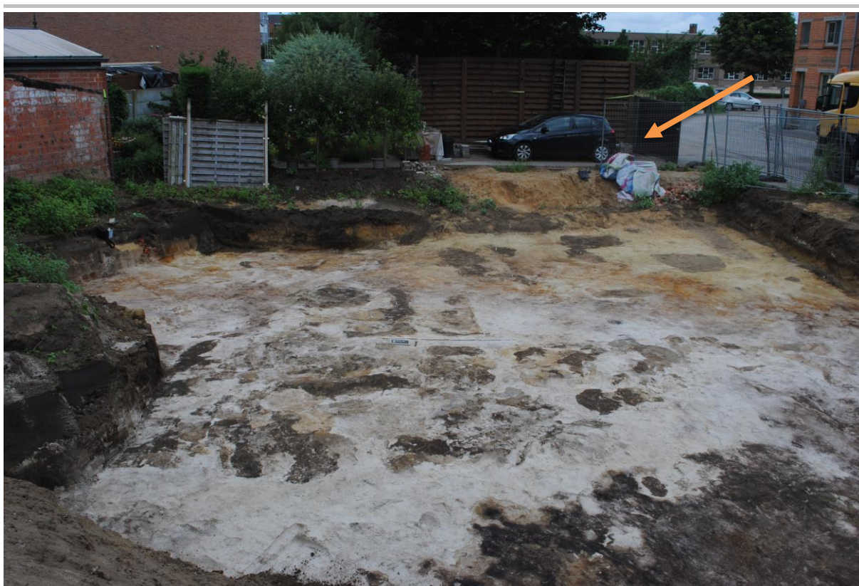
Fig. 2.3 Zicht op de oprit ter hoogte van de zuidwestelijke perceelsgrens
