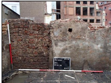
Figuur 72: Detailfoto S224/226: afgesloten kelderopening.
