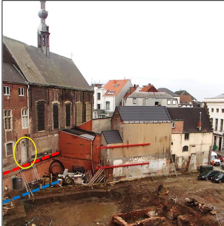
Figuur 10: Zicht op de kloosterkapel vanuit het zuiden. Duidelijk zichtbaar is dat de kapel en de overige kloostergebouwen op een verhoging werden gebouwd en dat er zo een niveauverschil ontstond met de aanpalende bebouwing. Rode lijn: straatniveau Schokkebroedersvest; Blauwe lijn: straatniveau Sint-Michielsstraat; Geel: Ingang kapel.
