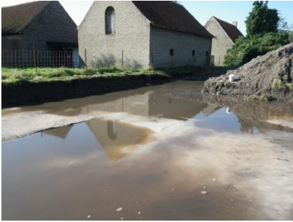
Figuur 8: Foto van het grondvlak na een wolkbreuk
