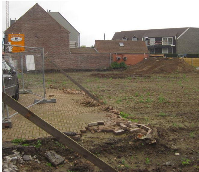
Figuur 1a-b: het onderzoeksterrein, voor én na de sloop
