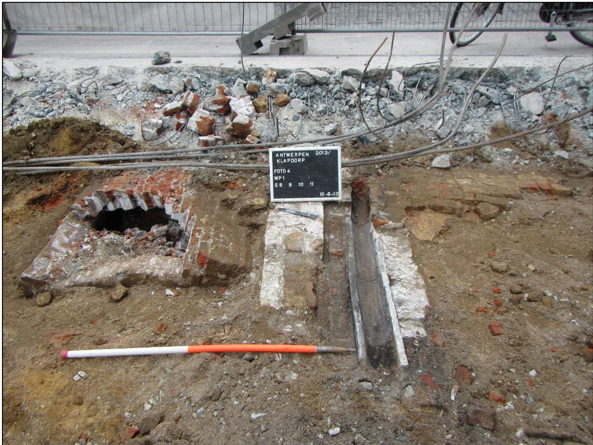
Figuur 89: Muur 1009 (centraal), gootje 1010 en resten van vloer 1011 (rechts)(richting NO)
