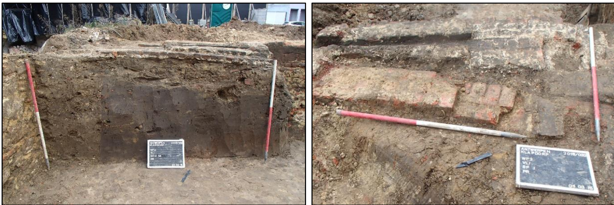
Figuur 104: Coupe op gootje 2068 (links, richting NW) en gootje 2068 naast muur 2067 (rechts, richting ZO)
