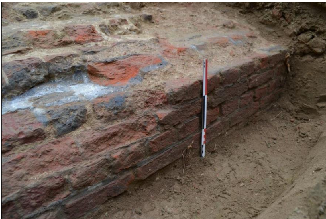
Figuur 38: Sleuf 5: detail van de herstelling van het parement, met donkergrijze trasmortel tussen de baksteenlagen en tussen de voegen.
