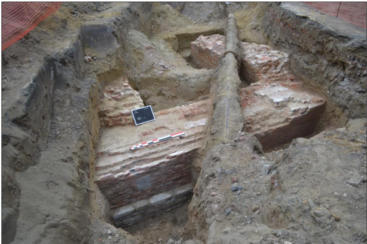
Figuur 18: De hoofdmuur van de citadel met 2 steunberen in sleuf 1.
