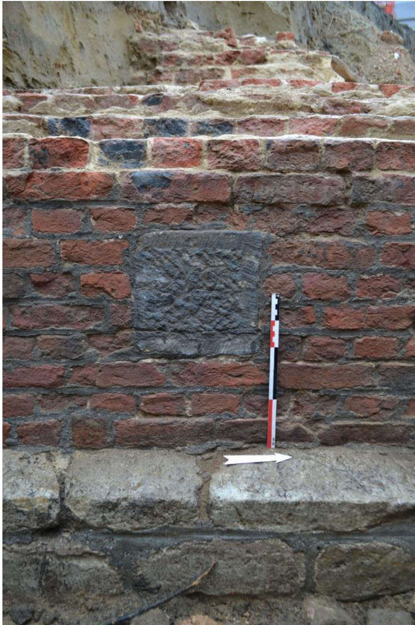
Figuur 19: Het parement van de hoofdmuur: gerestaureerd bakstenen metselwerk (S4) met muuranker (S5), en daaronder een natuurstenen parement (S7) dat opnieuw gevoegd werd.
