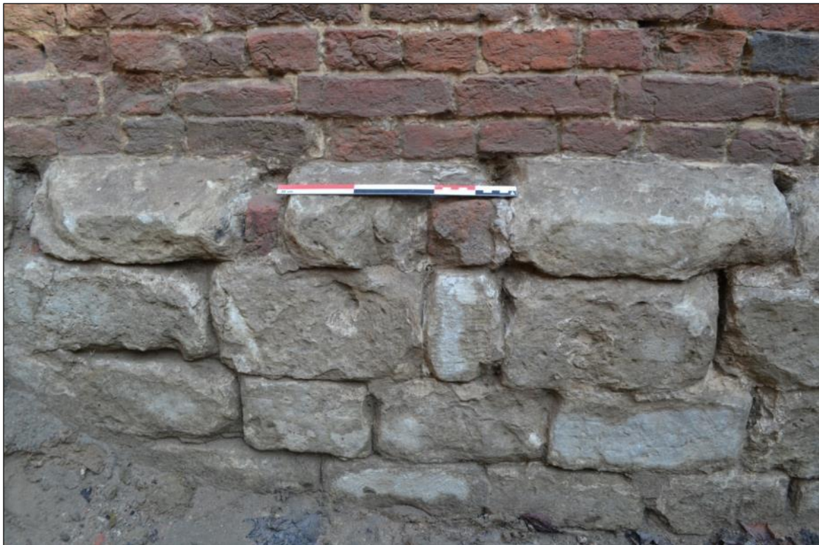
Figuur 21: Herstelling parement (S16) met baksteenbrokken in sleuf 2.
