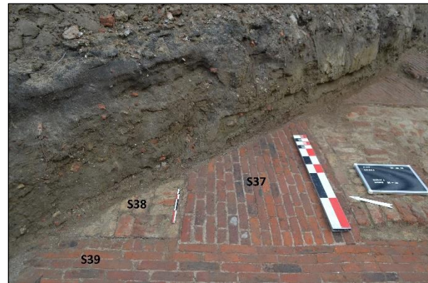
Figuur 35: Sleuf 4: detail van vloer S39 (tegen muur S38) en vloer S37, de doorgang van kamer 2 naar kamer 3 in de kazemat.
