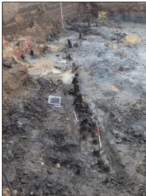
Figuur 25: Beschoeiing van de tweede (centraal) en derde (links achteraan) bedding van de Bommelaarsbeek
