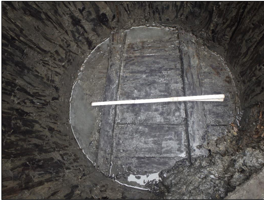
Figuur 90: Bodemplaat van tonwaterput S4098
