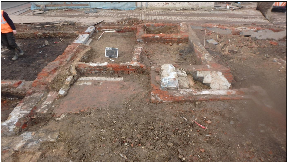
Figuur 145: Muurwerk en vloerniveau S1067 uit de derde bouwfase in de zuidwestelijke hoek van het onderzoeksterrein (richting ZW)
