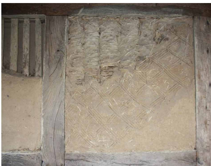
Afb. 9.44 Voorbeeld van vakwerk met ligger (pijl) en staken voor horizontaal vlechtwerk in het Duitse Openluchtmuseum Syke.
