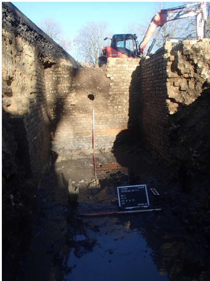
Figuur 36: Profielopname ter hoogte van de Hollandse vestingsmuur S.2.1.006 tussen twee steunberen. Centraal valt het uitbraakspoor ontstaan tijdens de recente aanleg van nutsleidingen op
