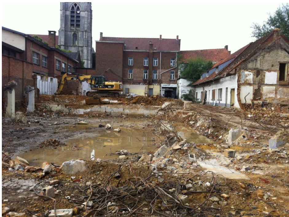
Figuur 2: zicht op de sloopwerken van de bovenbouw (04/07) met op de voorgrond de betonnen vloerplaat en pijlers van de voormalige filmzaal Familia
