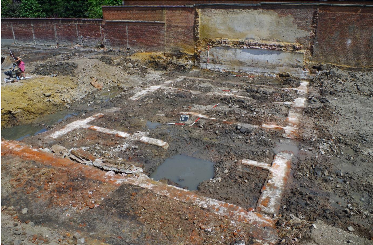
Figuur 6: zicht op het rechthoekige gebouw
