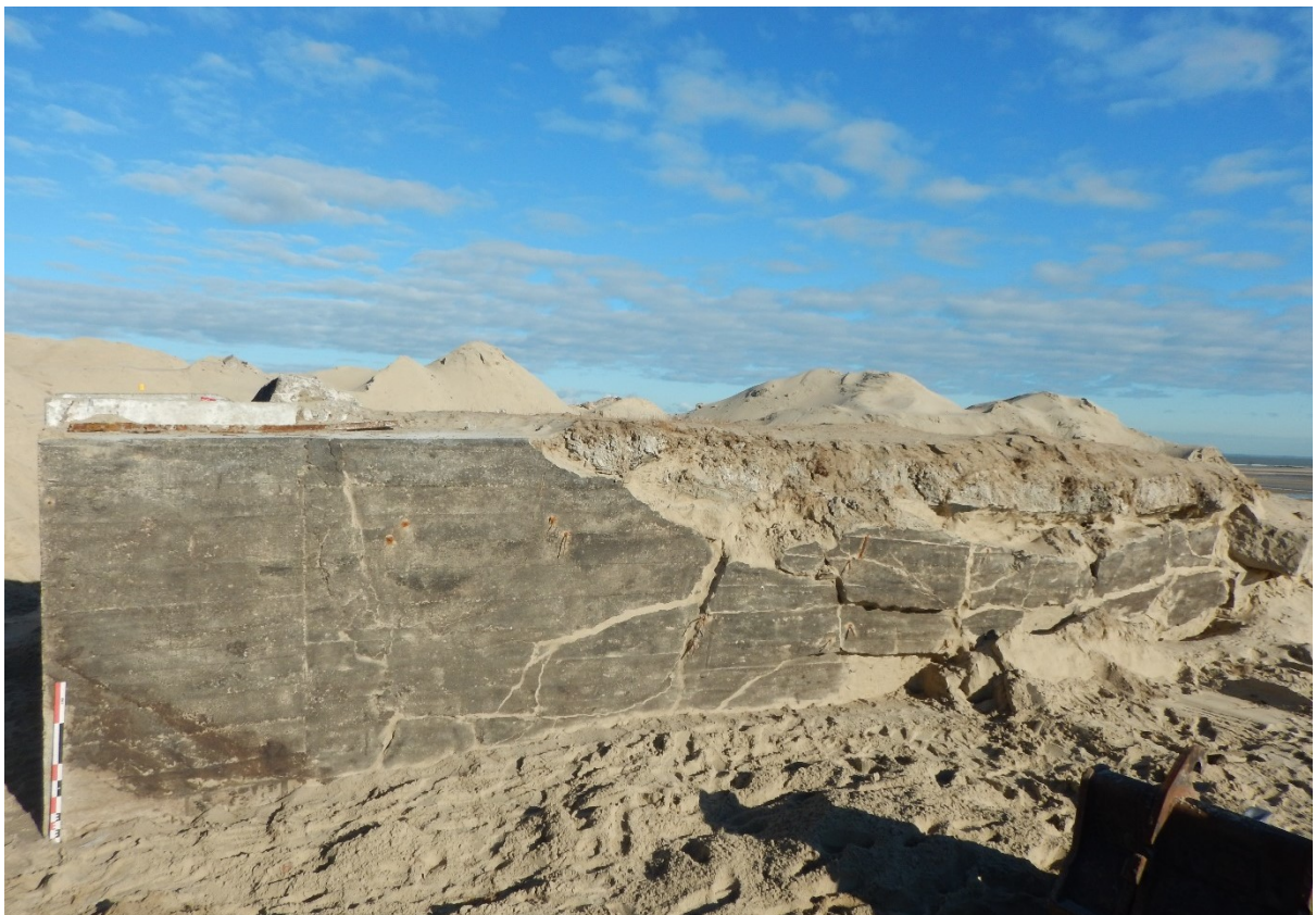
Fig. 70. De achterzijde van de bunker.
