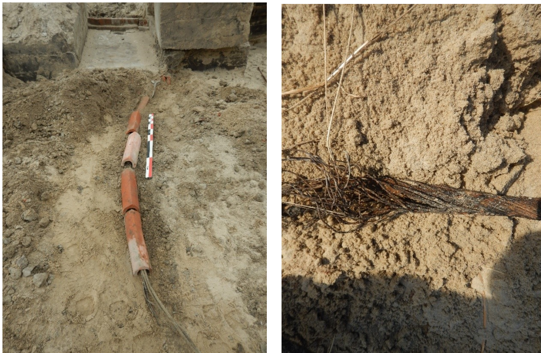
Fig. 148. KAB03 (links) en KAB01 (rechts).
