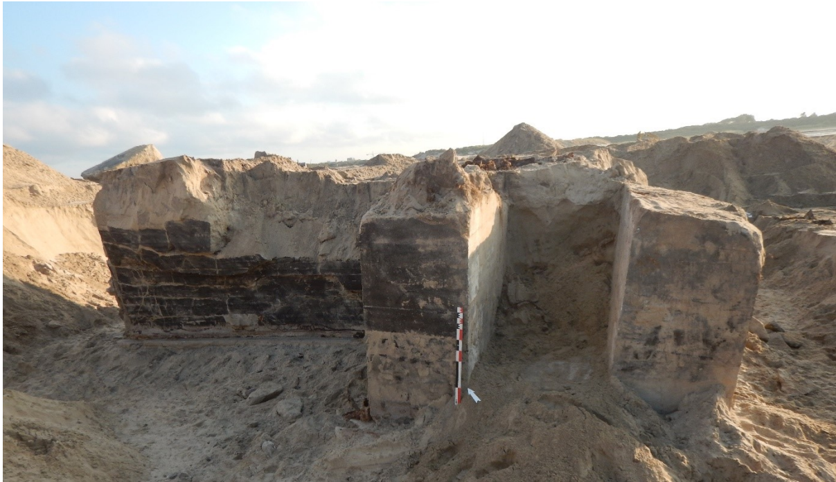
Fig. 231. Ingang BNR04. Deze ingang is 'gelijkvloers'.
