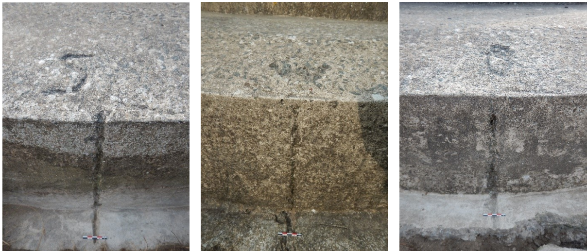
Fig. 91. Sud, West en Ost markeringen.
