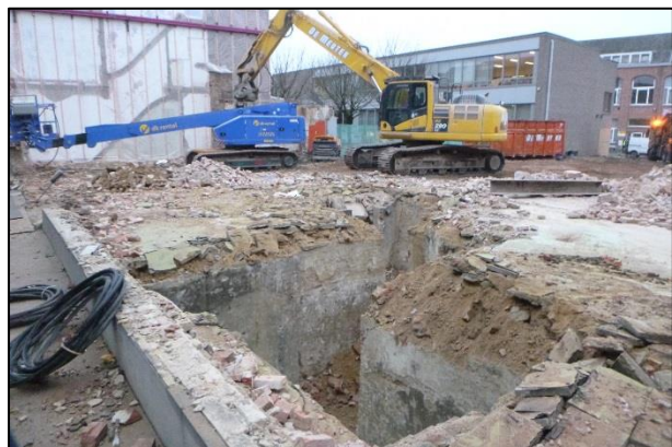
Figuur 31: Zicht op opgevulde kelders
