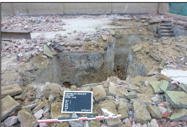
Figuur 30: Kelder 1 na sloopwerken
