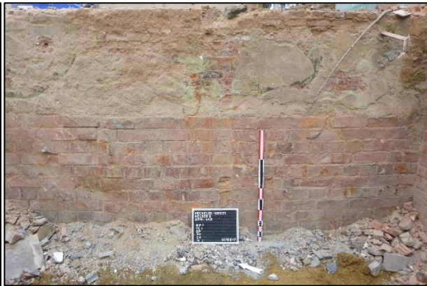
Figuur 33: Noord muur kelder 2
