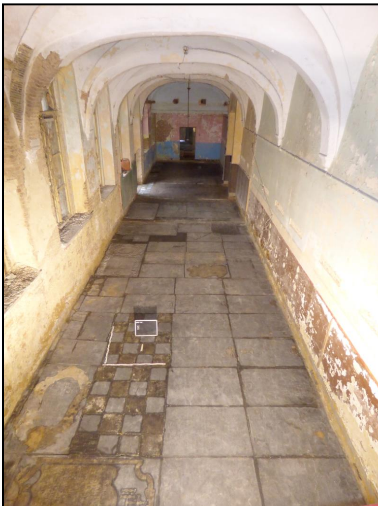
Figuur 6: zicht op de oostelijke pandgang met vloer uit gerecupereerde grafstenen (SMEETS e.a. 2017).
