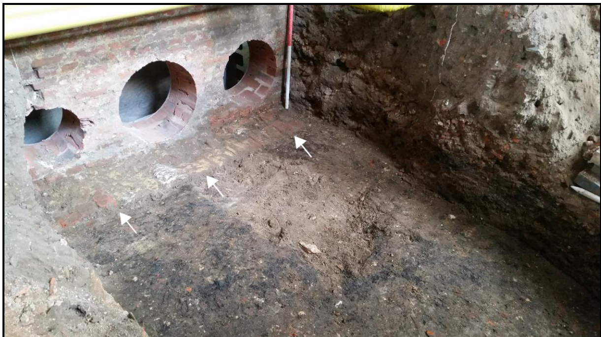
Figuur 17: zicht op de fundering van de pandgang (oostmuur). Achterliggend is de kelderruimte te zien.
