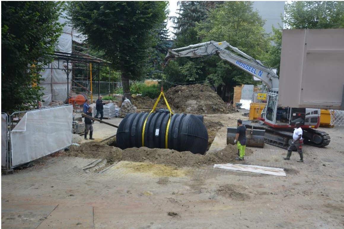
Fig. 2.3: Het steken van regenwaterputten op de speelplaats.
