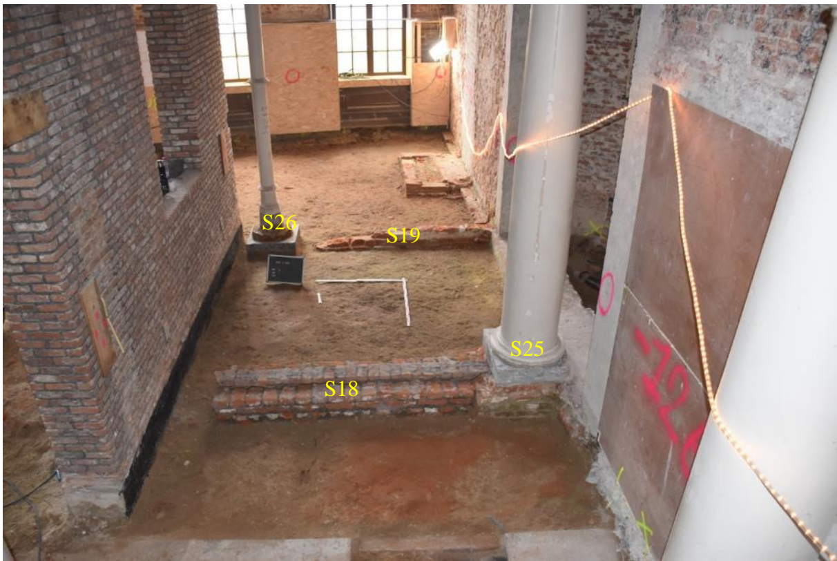
Fig. 3.19: Binnenmuren S18 en S19 in ruimtes E1 tem E4.
