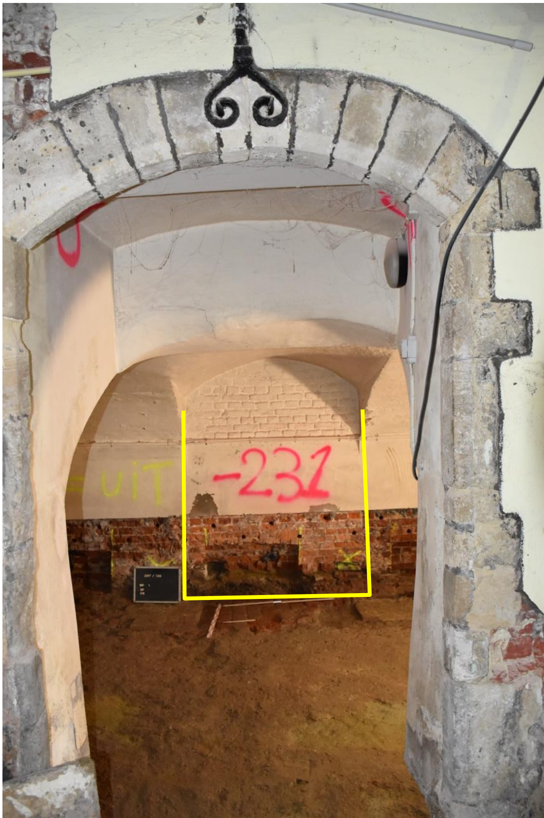
Fig. 3.10: Dichtgemaakte deuropening tussen kelders A2 en A1.
