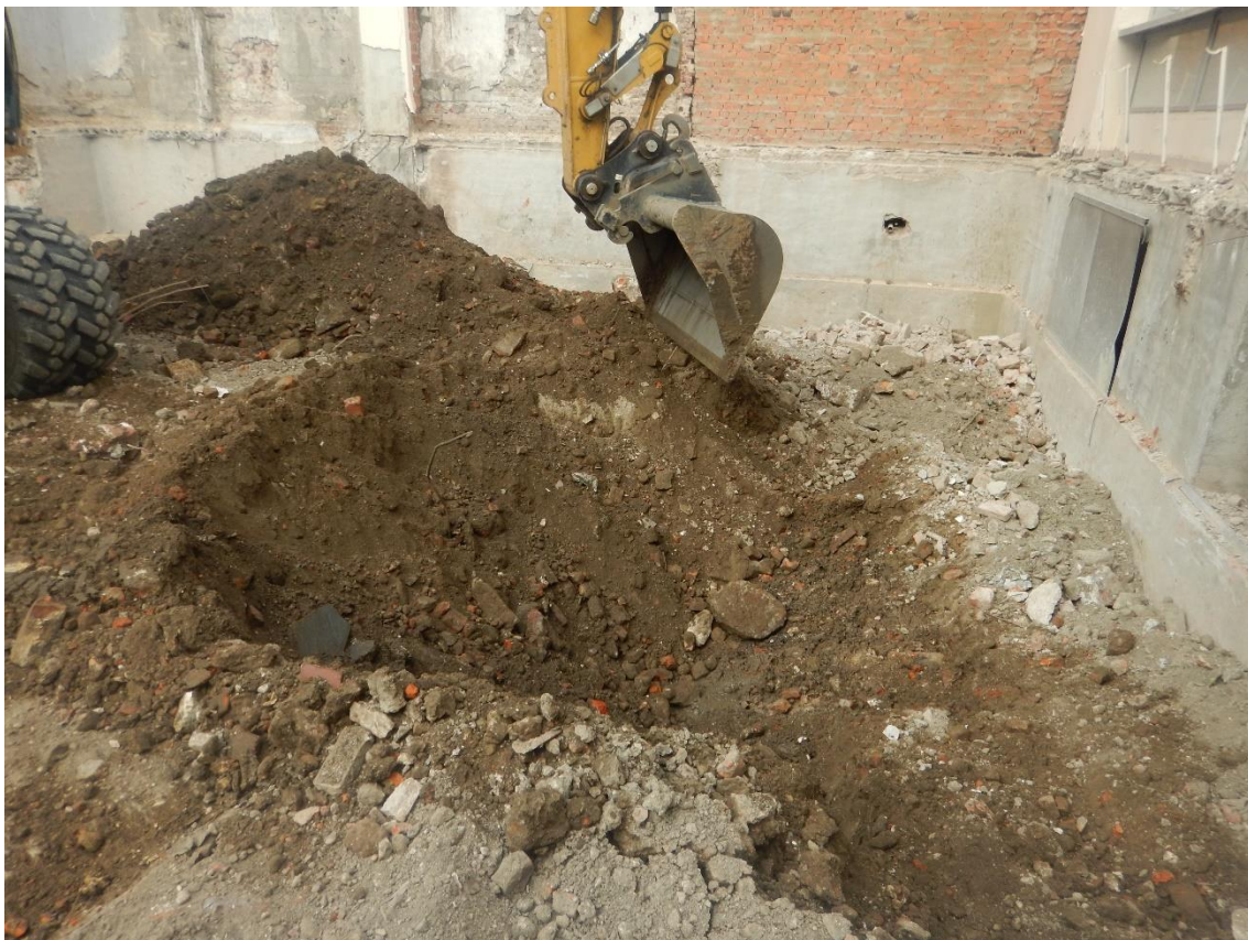
Figuur 14: Werkput in noordwesthoek onderzoeksgebied.
