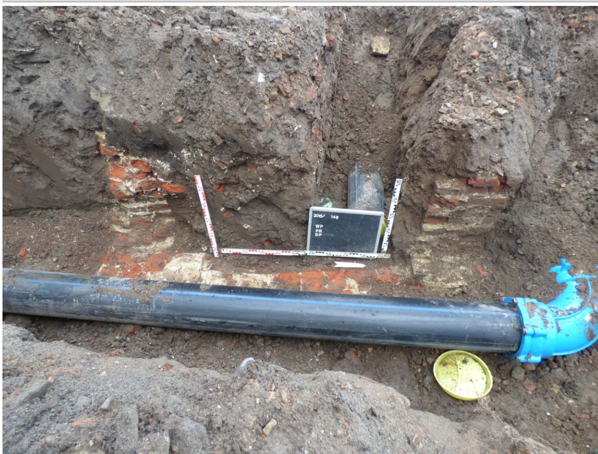
Fig. 3.2: Bakstenen structuur (S1) in WP1.
