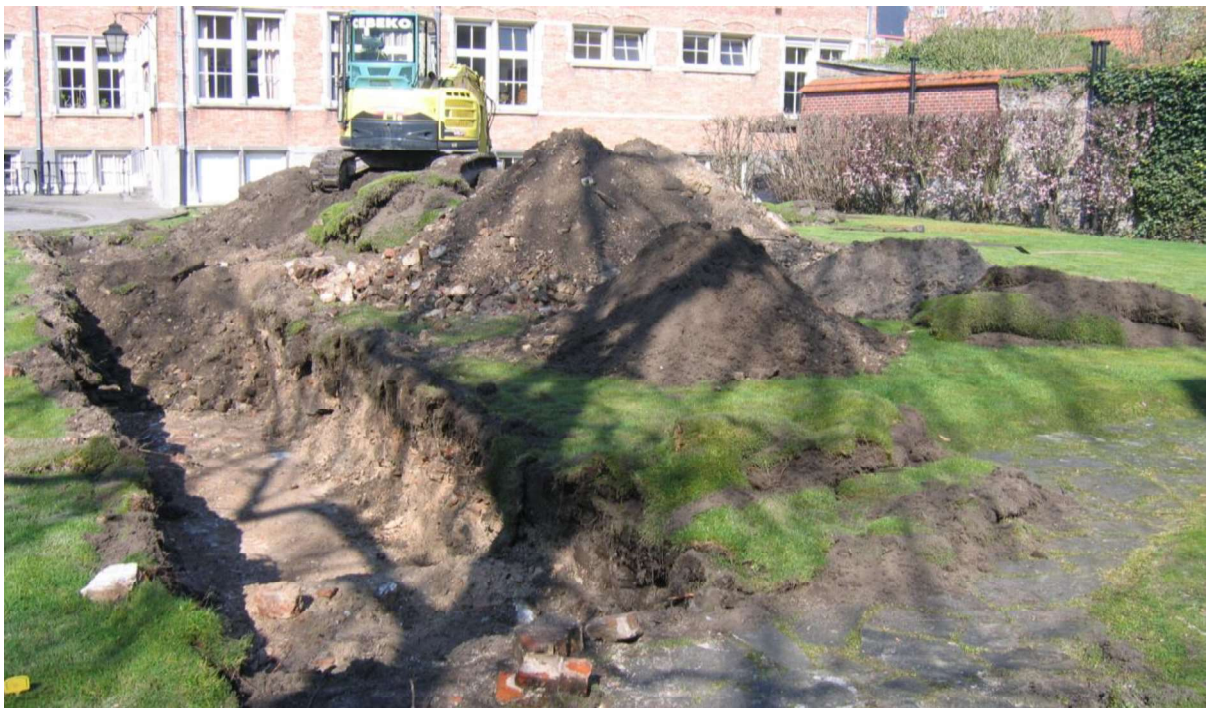
Het graven van de eerste sleuf.
