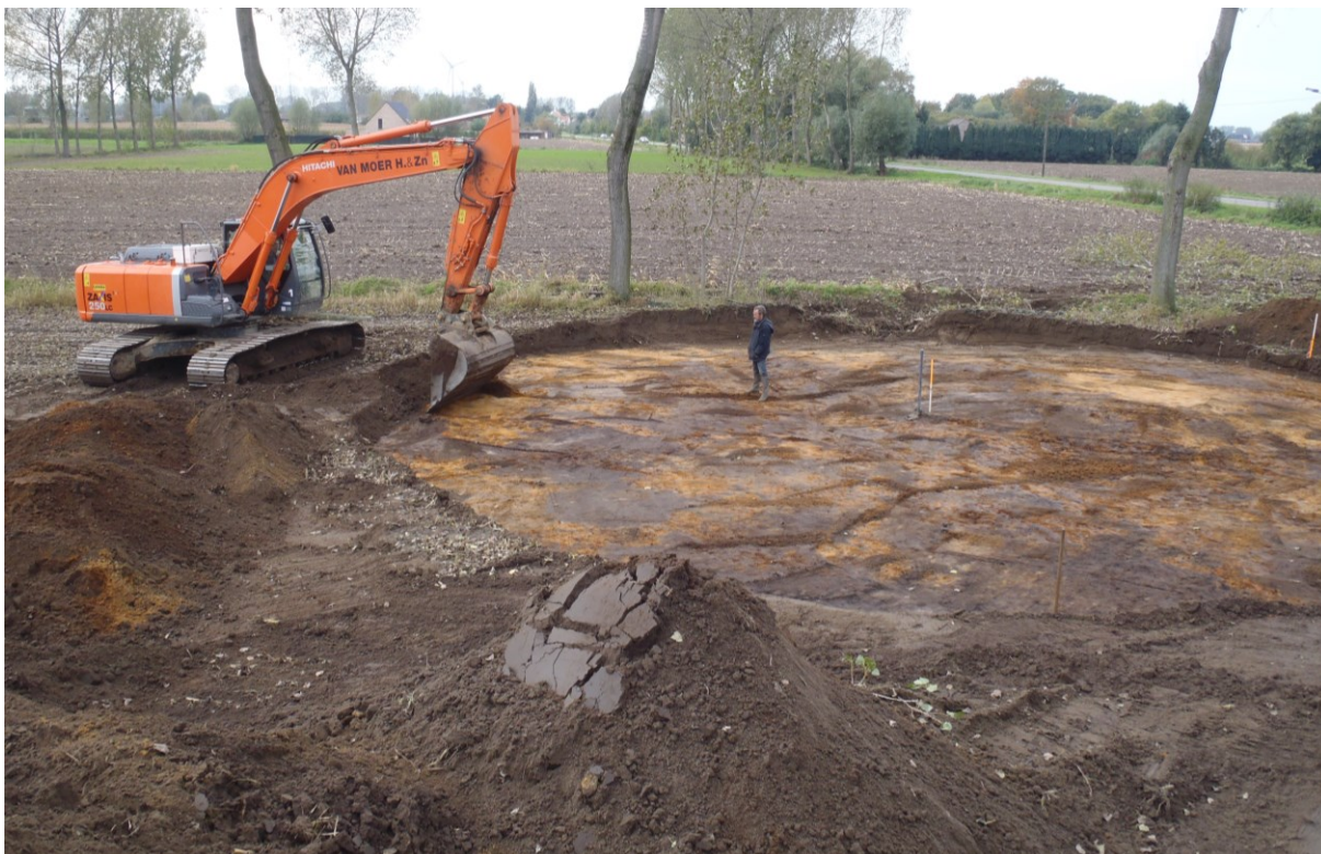
Fig. 4. Afgraving van het zuidwestelijke deel van het onderzoeksvlak.
