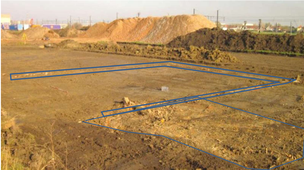
Figuur 12: Funderingen van de gesloopte gebouwen (S3 en S4) in het vlak
