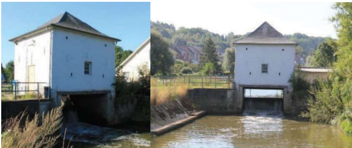
Figuur 25: Huidige toestand van het noordelijke stuwgebouw.
