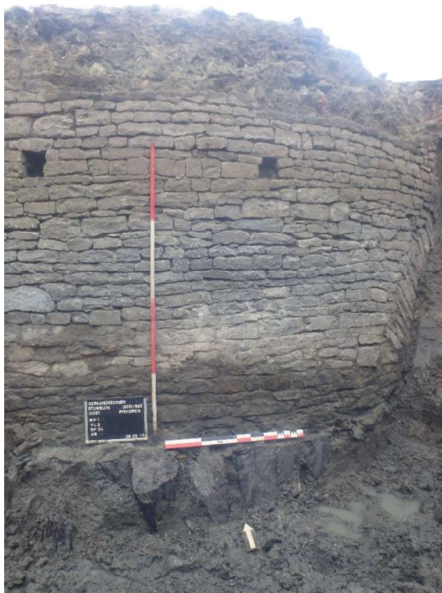
Figuur 78: Foto van de opbouw van de Pijntoren langsheen de veldzijde, de aanzet van de spaarboog is rechts zichtbaar. De houten funderingspalen zijn zichtbaar onder de schaalbalk.
