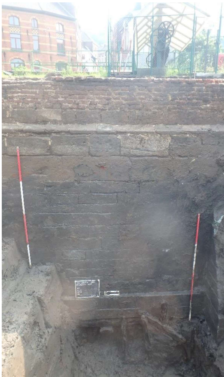
Figuur 113: Profiel langs de westzijde van het molengebouw.
