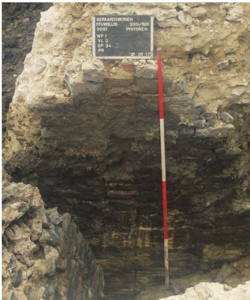
Figuur 83: detailfoto van de met baksteenfragmenten opgevulde uitsparing langs de zijkant van de Pijntoren ter hoogte van de aansluiting met stadsmuur 1039.
