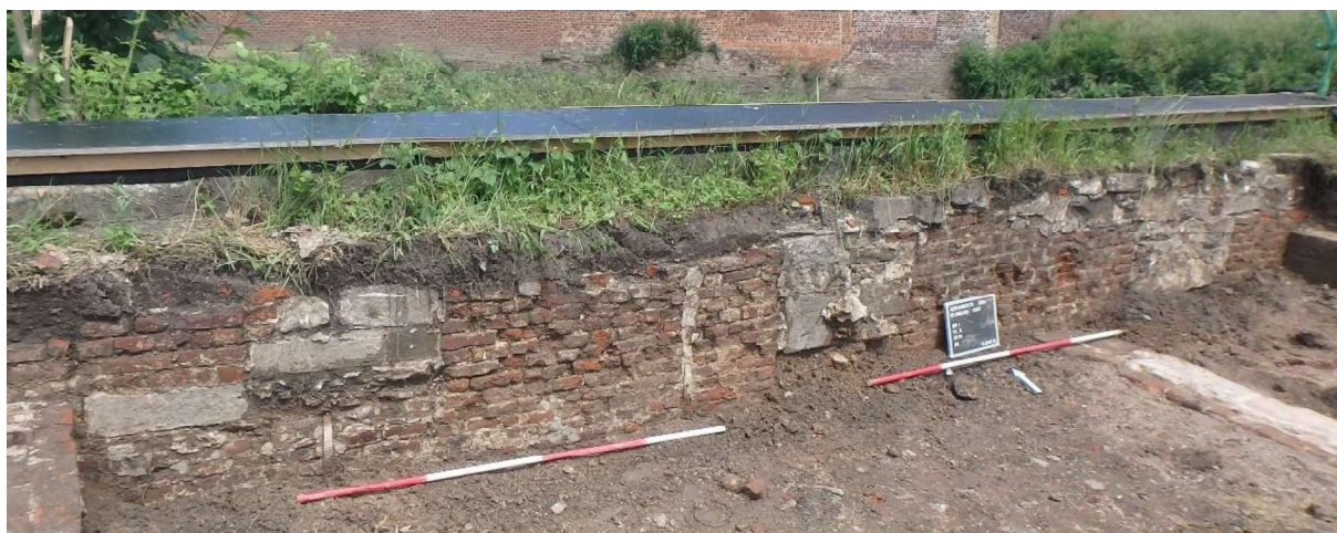
Figuur 118: noordelijke muur van het gebouw met drie opgevulde raamopeningen.
