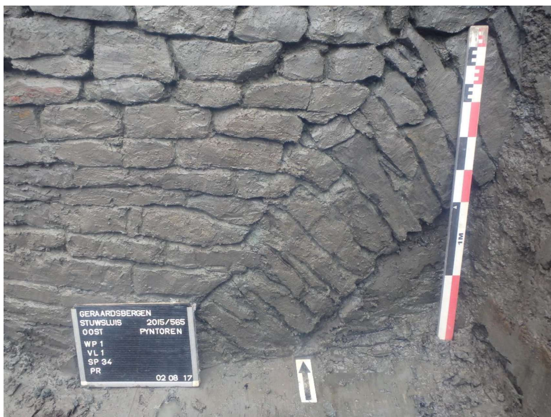
Figuur 79: Detailfoto van de spaarboog aan de veldzijde met zicht op de zorgvuldig gehouwen stenen.
