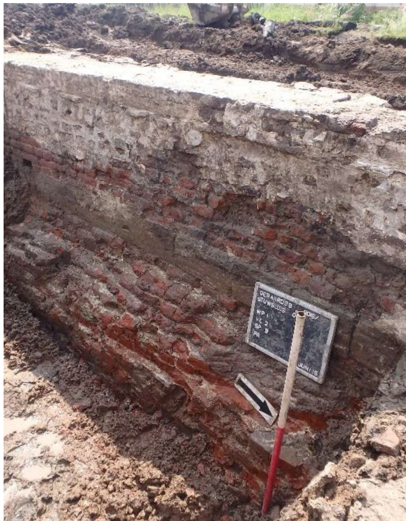
Figuur 121: Fundering aan de binnenzijde van de westmuur.
