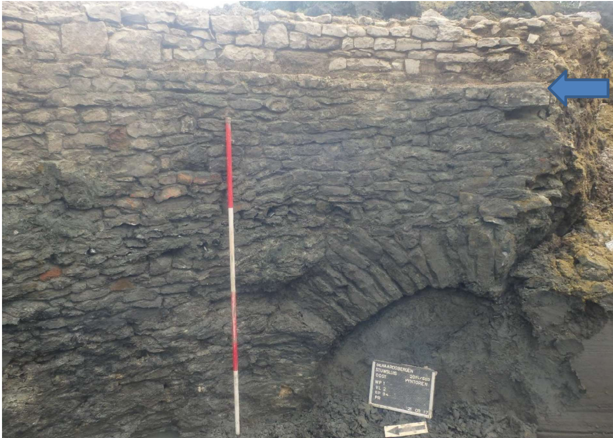
Figuur 74: Detailfoto van de binnenzijde van de veldzijde van de Pijntoren met detail van de spaarboog en bovenaan de vertanding van de muur.
