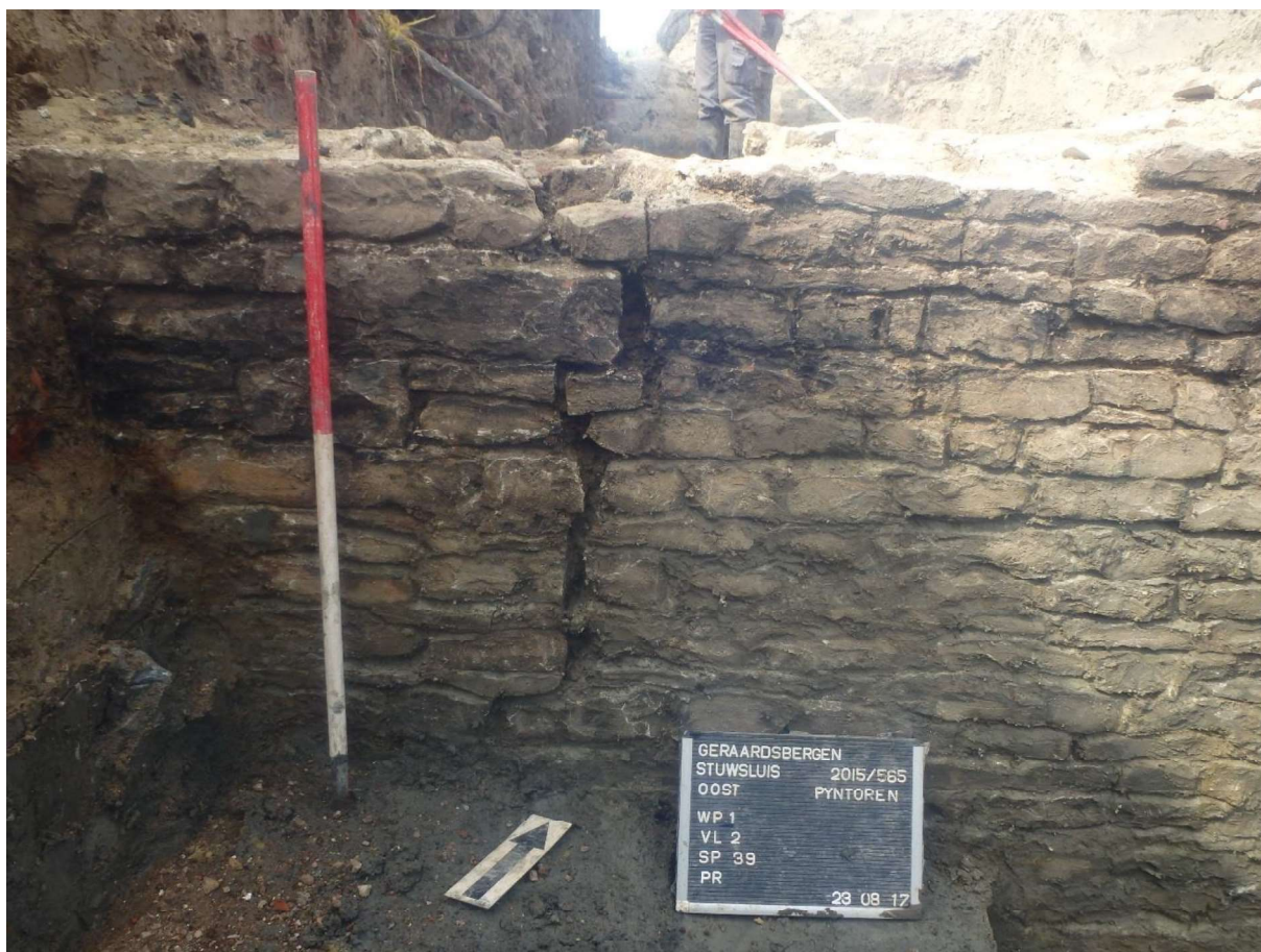
Figuur 96: barst in muur 1039.
