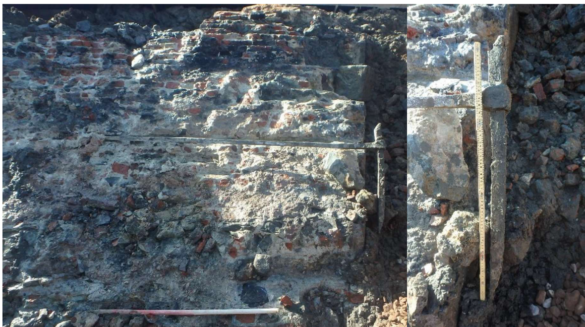
Figuur 36: Muuranker in de bakstenen kern.
