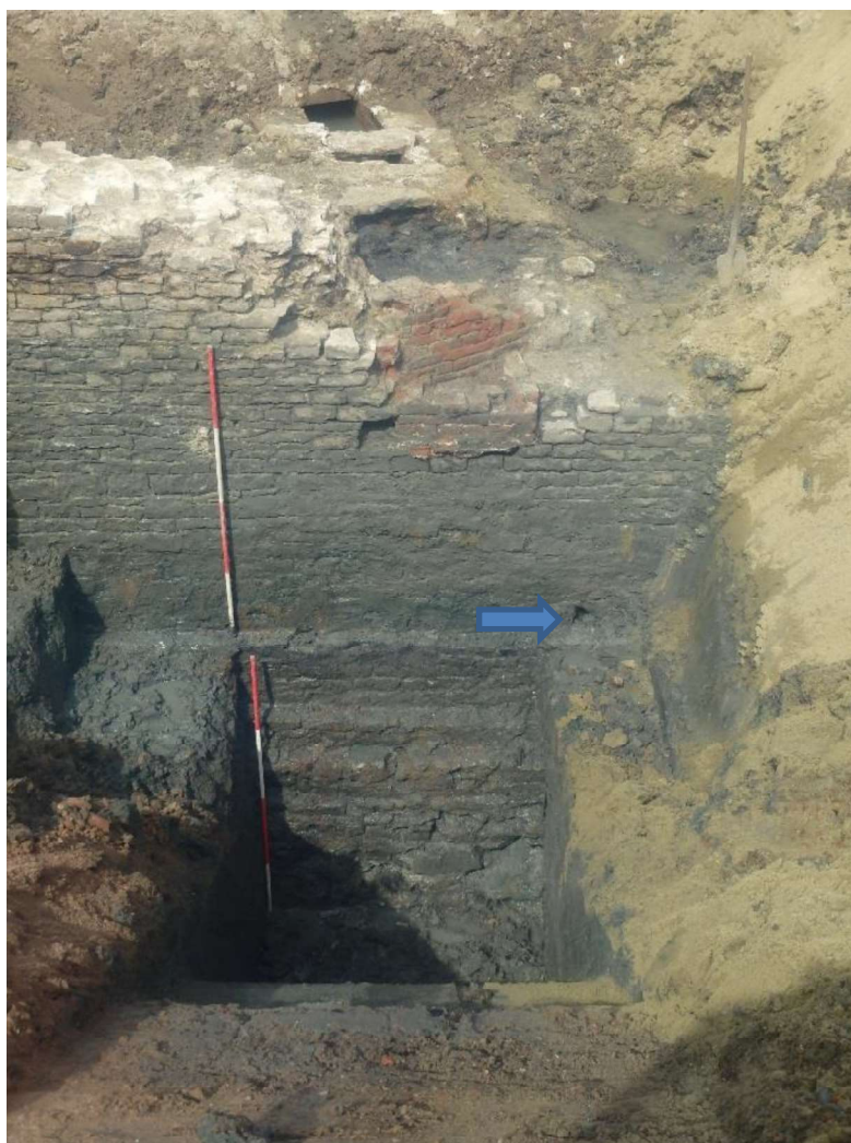
Figuur 92: zicht op de veldzijde van de stadsmuur. De aanzet van de spaarboog is met een pijl aangegeven.
