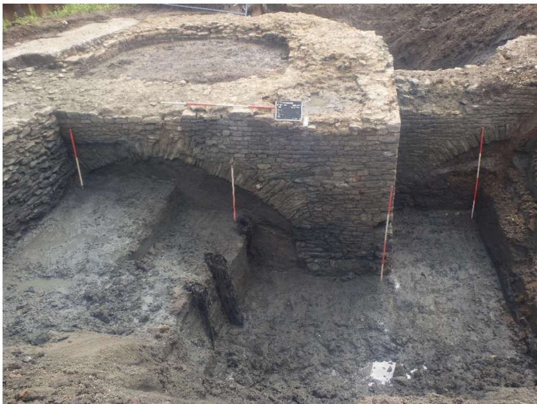
Figuur 81: foto van de stadszijde van de Pijntoren met duidelijk zichtbare spaarboog.
