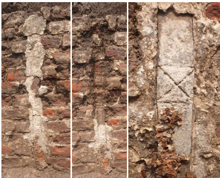
Figuur 119: Links en midden: twee muurankers in noordmuur; rechts: detail van ingekerfd kruis.
