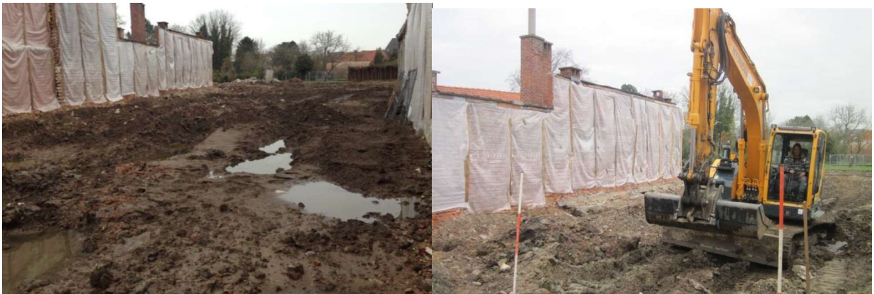
Figuur 12: het terrein na de sloop van de bebouwing (l) en tijdens de aanleg van de sleuven (r)
